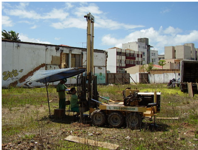
FIGURA 17 - Equipamento de cravação
