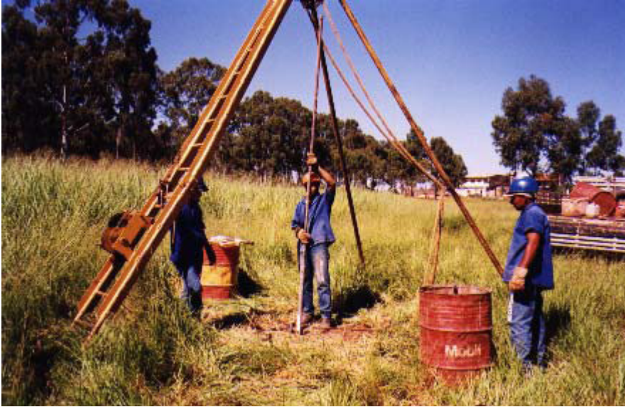
FIGURA 30 – Foto da execução do ensaio SPT FONTE: Francescato (2004)
