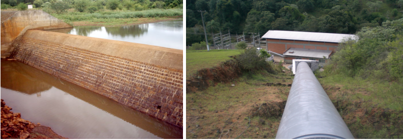
Figura 8a Pequena Usina Hidrelétrica construída pelo Frigorífico Anhambi
