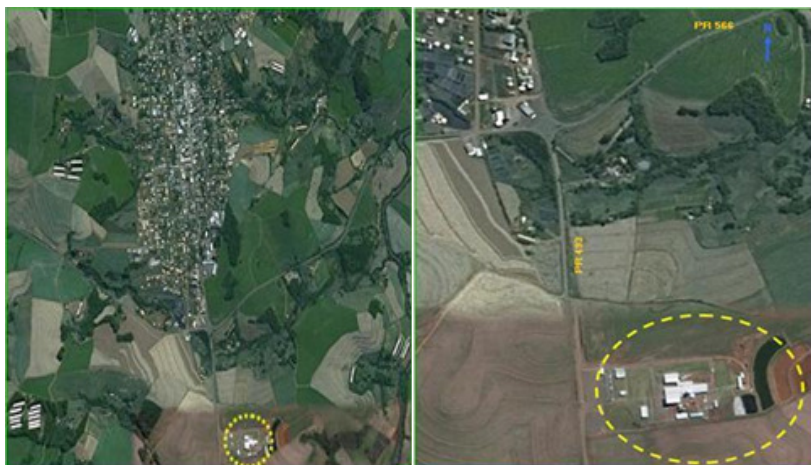
Figura 13 Visão do Frigorífico Anhambi quanto à sua localização geográfica no município Fonte: Google Earth, 2009.
