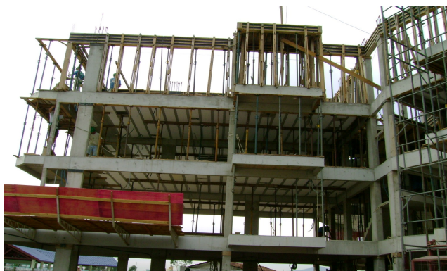
Figura 12 - Etapa de Supraestrutura 03
