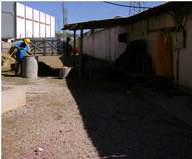
Figura 8 - etapa de serviços preliminares
