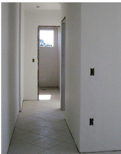
Figura 30 - Etapa de Pintura
