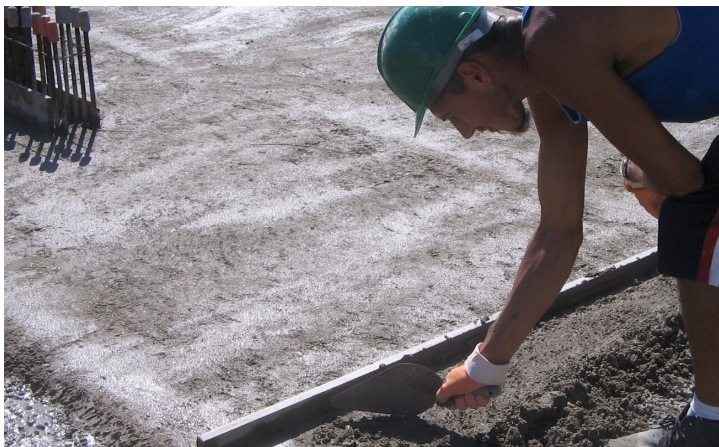
Figura 26 - Etapa de Pavimentação 01
