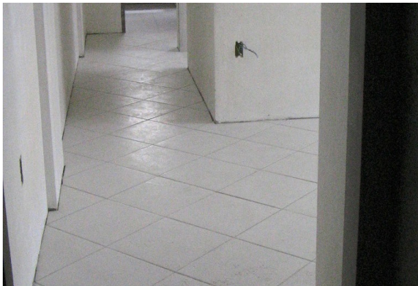
Figura 28 - Etapa de Pavimentação 03
