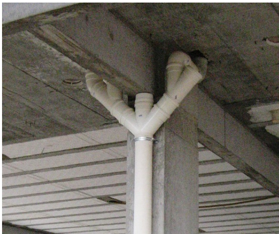
Figura 15 - Etapa de Instalações Hidráulicas 01.
