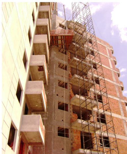
Figura 25 - Etapa de Revestimento Externo 02
