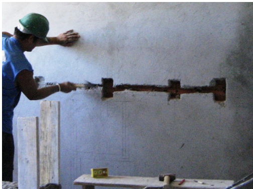
Figura 18 - Etapa de Instalações Elétricas 01
