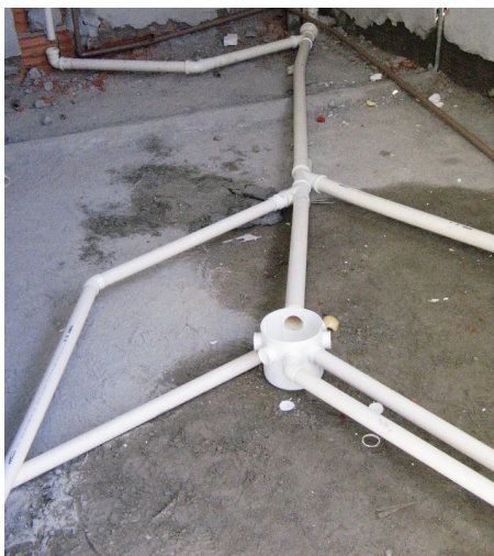
Figura 16 - Etapa de Instalações Hidráulicas 02
