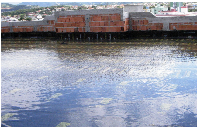
Figura 29 - Etapa de Impermeabilização com manta asfáltica
