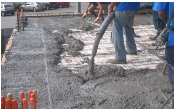
Figura 11 - Etapa de Supraestrutura 02
