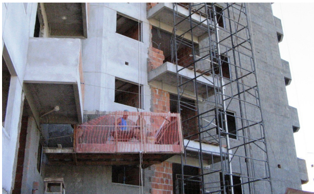
Figura 24 - Etapa de Revestimento Externo 01
