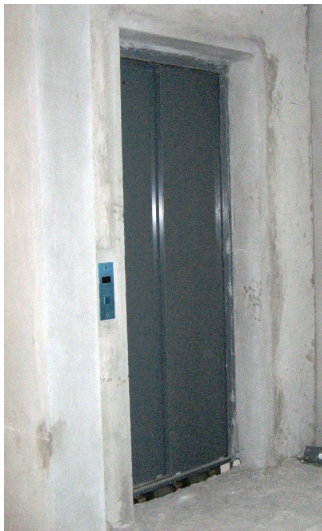
Figura 20 - Etapa de Instalações de Elevador
