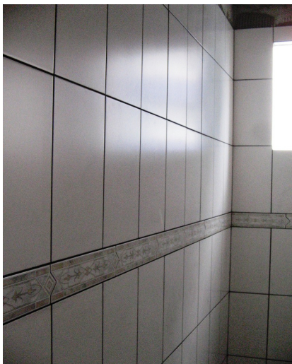
Figura 23 - Etapa de Revestimento Interno 02
