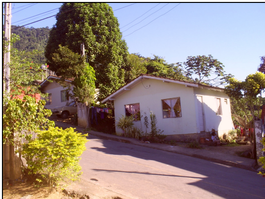
Figura 23 - Casas construídas no Projeto Jaraguá 84
