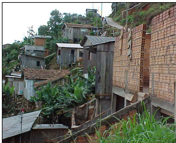
Figura 14 - Casas em situação de risco demolidas
