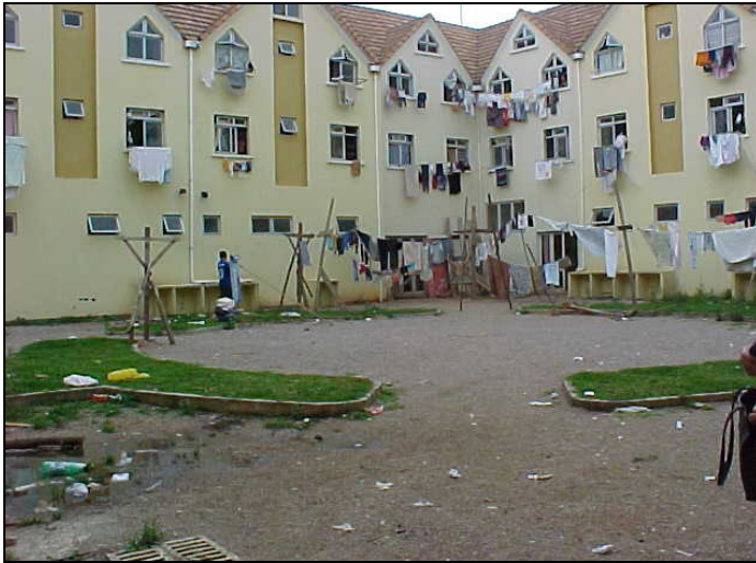
Figura 16 - Prédio construído pelo programa HB que serviu de abrigo provisório aos beneficiados do Programa HBB
