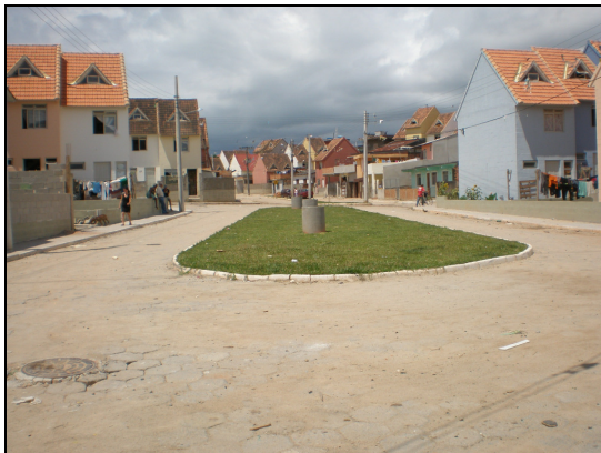
Figura 18 - Infraestrutura – Setor D
