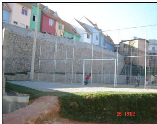
Figura 19 - Muros de contenção e quadra
