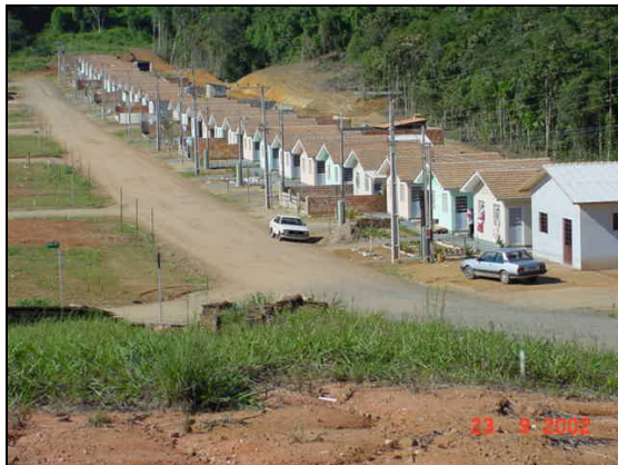
Figura 26 - Obras de acesso a Jaraguá 84
