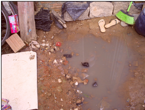
Figura 33 - Esgoto do Loteamento José Nitro lançado no Loteamento Morar Bem
