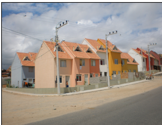
Figura 17 - Casas construídas setor D
