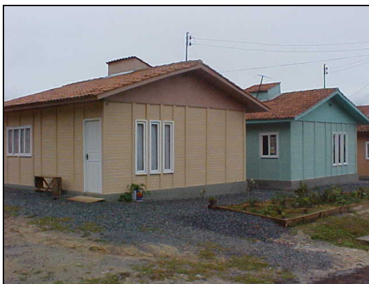
Figura 22 - Casas construídas no Projeto Jaraguá 84
