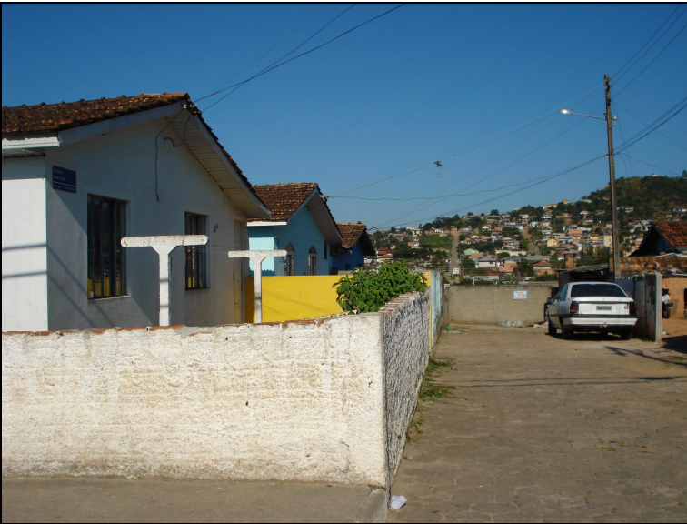
Figura 39 - Rua do Loteamento José Nitro sem acesso ao novo loteamento
