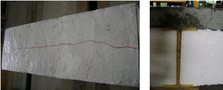
Figura 3.21 – Fissura no V3
