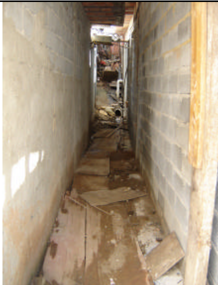
FCT-RP-10 - Vista de uma das vielas da área. Observar que os depósitos encontram-se nivelados. Parte destes está coberto por tábuas de madeira e parte sob as moradias.
