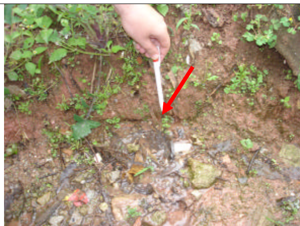
FCT-RP-02c - Notar a saturação no depósito de solo lançado. Há uma surgência d'água que permeia entre o contato da superfície do talude de corte e a base do depósito.
