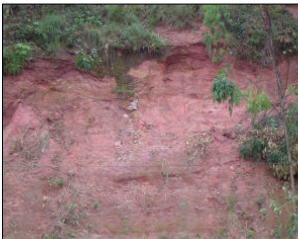
Foto 06 – Detalhe de um talude de corte expondo o solo saprolítico roxo, resultado da alteração do micaxisto porfiroblástico parcialmente migmatizado.
