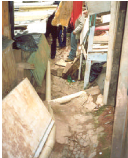
FC-RP-21 -Vista geral de uma viela com boa infra-estrutura, apresentando esgoto canalizado, pavimentação e drenagem superficial.
