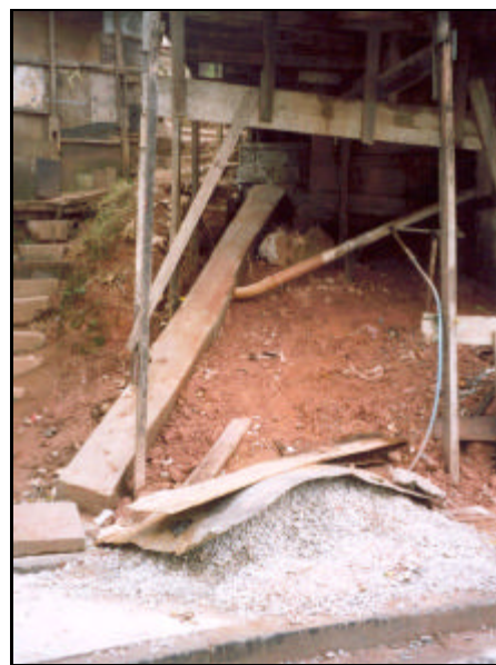
Foto 16 – Detalhe da canaleta de drenagem executada por técnicos da subprefeitura do Butantã.
