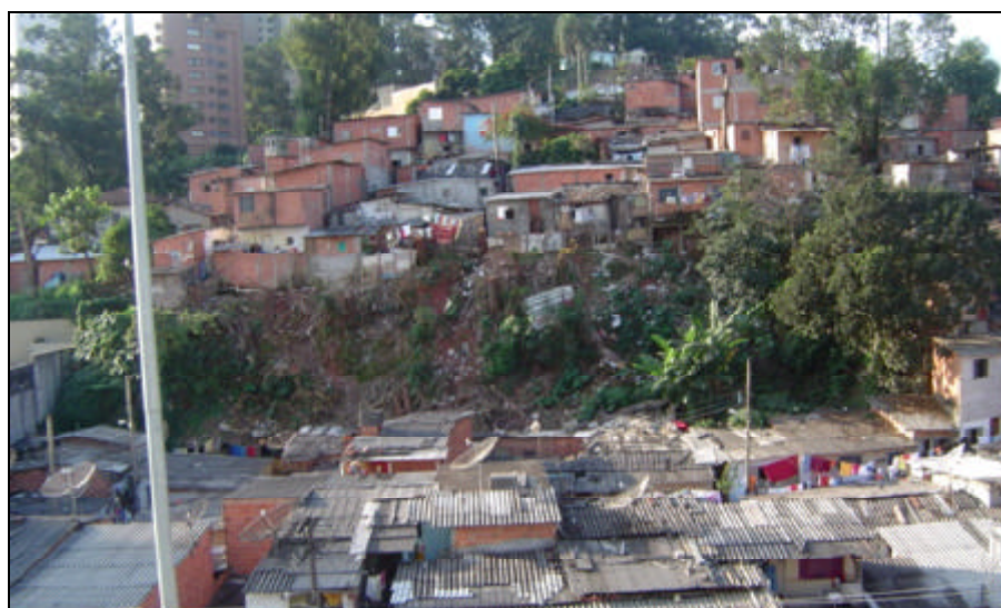
Foto 12 – Vista geral do talude de grandes dimensões localizado no quadrante sudoeste.
