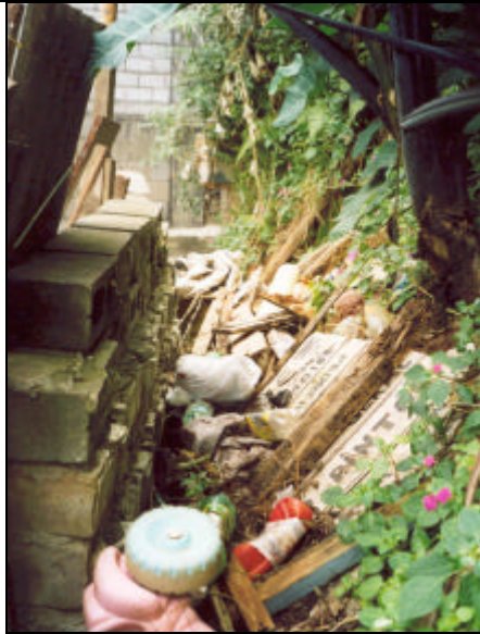
FC-RP-13 - Detalhe da concentração de lixo e entulho entre a base do talude observado no ponto 1 e a parede de uma moradia. Observar a proximidade da moradia em relação a base do mesmo.
