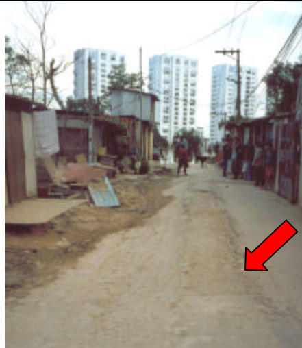
FC-RP-23 - Vista geral da rua Conde de Itaguaí, a qual marca o limite superior da área de estudo. Observar a presença de um degrau de abatimento localizado no local onde ocorreu, em 1994, um escorregamento gerado pelo rompimento de uma adutora da Sabesp.
