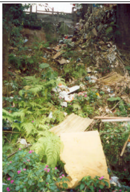
FC-RP-01b - Observar o acúmulo de lixo e entulho ao longo do talude de corte. Este material é lançado pelos moradores que residem a montante do topo do talude.
