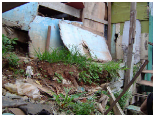
FC-RP-03c - Detalhe de um depósito de solo lançado, contendo lixo e entulho em sua composição. Notar o início da construção de uma moradia de madeira sobre este.
