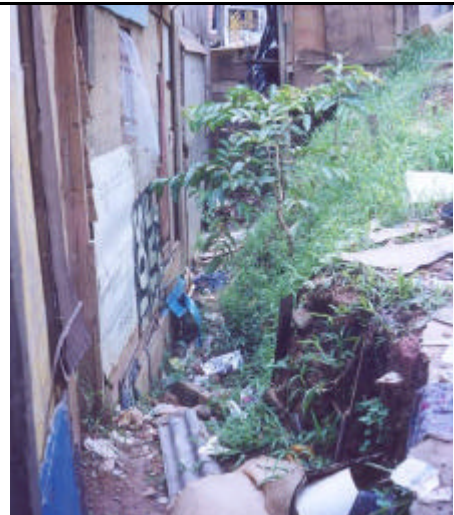
FC-RP-24a - Talude de corte de pequenas dimensões. Observar a proximidade deste em à moradia e a presença de lixo e entulho no local.
