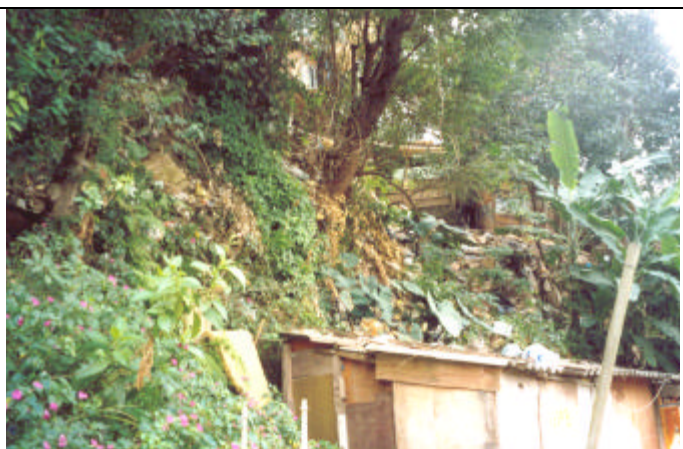
FC-RP-01c - Detalhe de uma das moradias localizadas na base do talude de corte. Observar a proximidade desta em relação ao mesmo.
