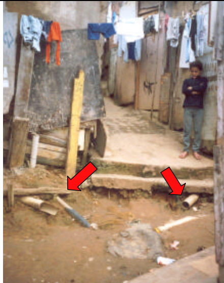
FC-RP-04 – Vista parcial de uma das vielas da favela. Observar a presença de canos de PVC direcionadas para a mesma. Estes lançam esgoto e água servida a céu aberto.
