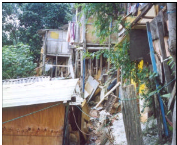
Foto 10 – Vista parcial das moradias localizadas no quadrante sudoeste da área.
