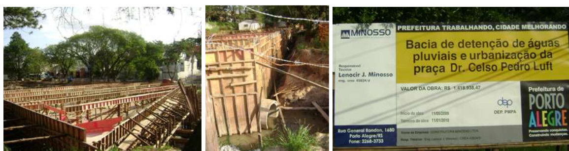
Figura 8.10. Fotografias do reservatório em construção na Praça Doutor Celso Luft.
