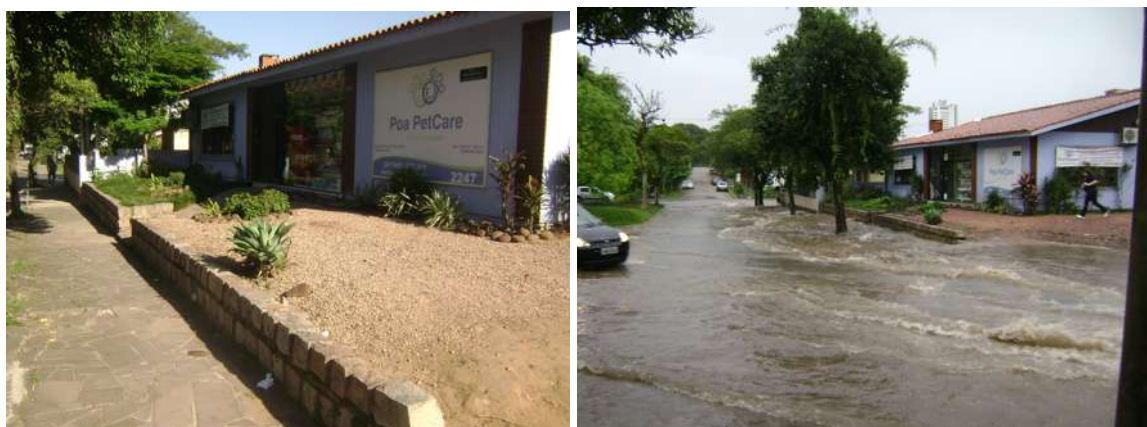
Figura 5.48. Modificação empregada por um proprietário para conviver com os constantes alagamentos.
