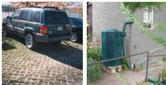
Pavimento permeável em um estacionamento (esquerda) e microrreservatório em uma residência (direita).
