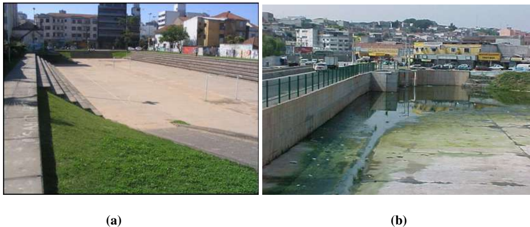
(a) (b) Figura 2.2. Bacias de detenção localizadas em uma praça do município de Porto Alegre (a) e ao lado de uma rodovia em São Paulo (b).
