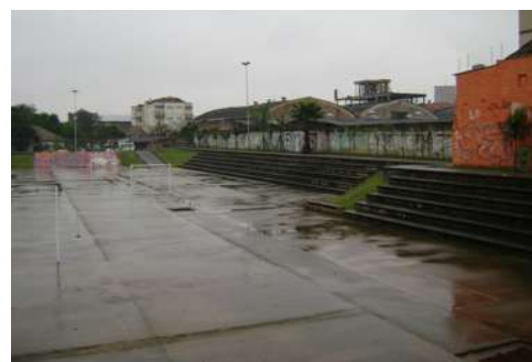
Exemplos de reservatórios de amortecimento (piscinões).
