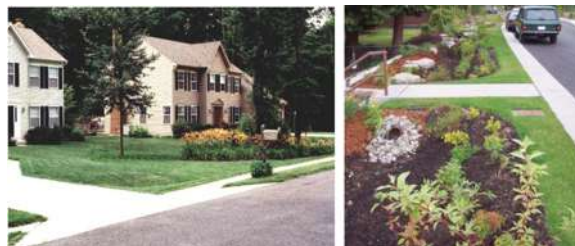
Trincheira de infiltração associada a um jardim em uma residência.
