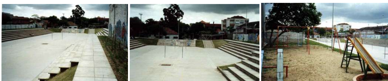
Figura 8.4. Fotografias do reservatório de detenção da Praça Julio Andreatta.
