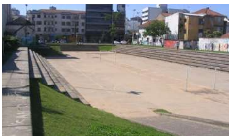
Reservatório de amortecimento (piscinão) – Porto Alegre.
