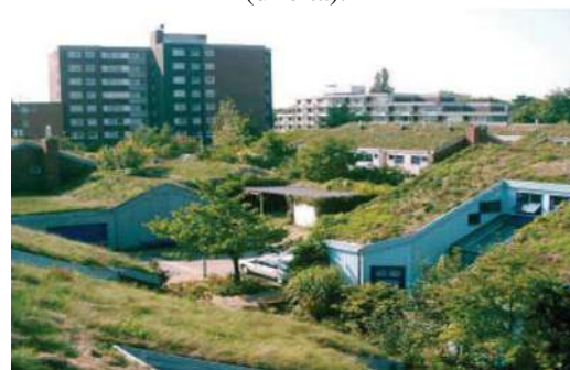
Telhados verdes em residências.
