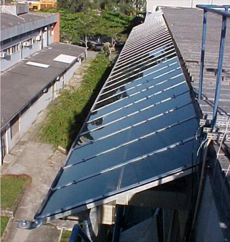
**Figura 29. Primeiro sistema fotovoltaico conectado à rede e integrado a uma edificação no Brasil: Sistema de 2 kWp localizado em Florianópolis-SC, em operação desde 1997.**
