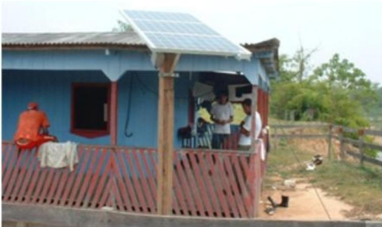
**Figura 17. Sistema fotovoltaico isolado para abastecer uma residência em área rural sem acesso à energia elétrica.**
