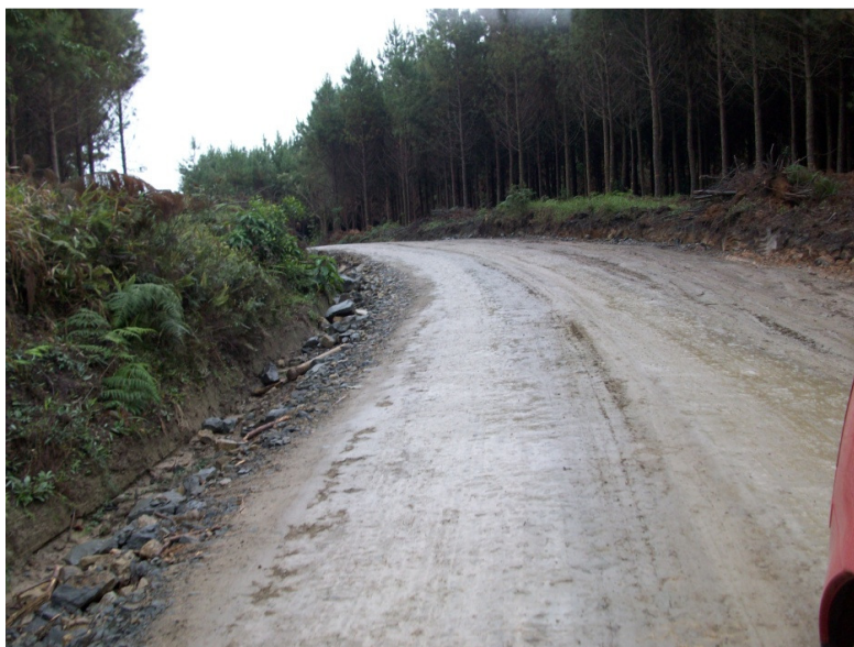
Figura 29 – Foto do canal da estrada da área de estudo
