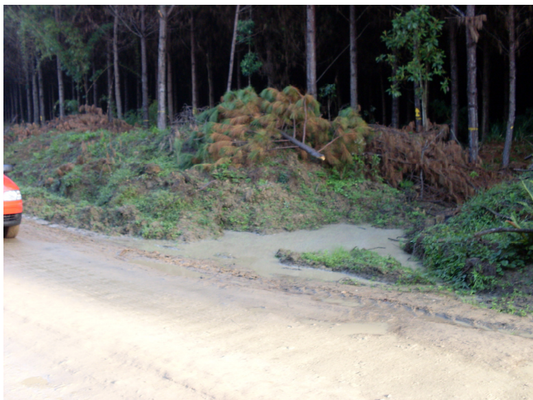
Figura 81 – Ineficiência de uma bacia de acumulação em campo
