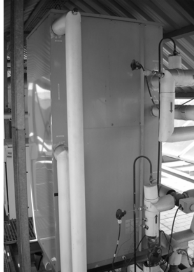
Figura 5.23 – Máquina de Absorção.
