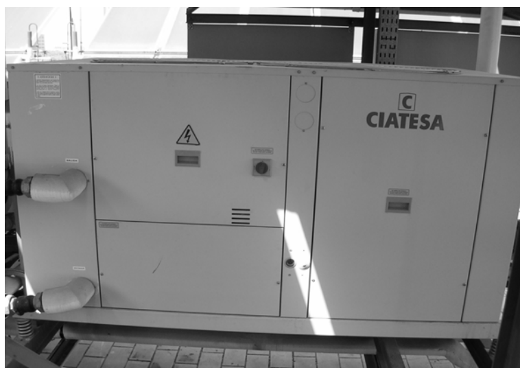
Figura 5.22 – Bomba de Calor.
