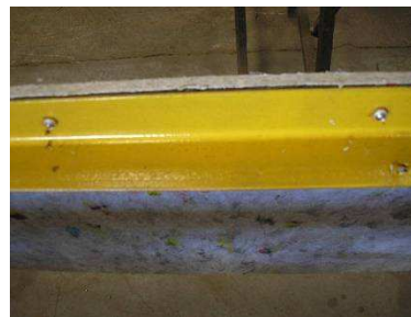
(b) fixação por meio de rebites entre dois grupos de materiais diferentes, com aumento do tempo para desmontagem
