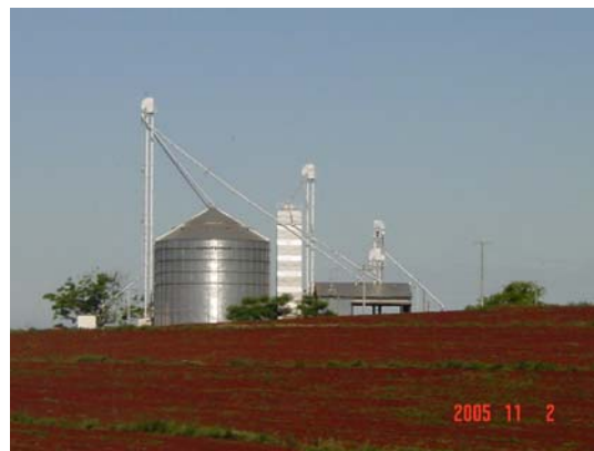
Infra-estrutura material. Silo para armazenamento de grãos. Bacia do Ribeirão dos Apertados.
