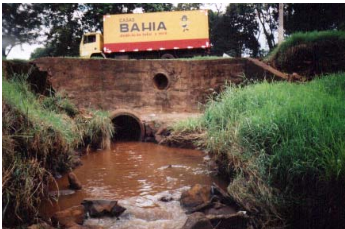
Autora: A. Perini, 2003 Vista lateral do aterro , (acima passagem da rua Theodoro Braúko), e vista dos tubulões de passagem das águas barrentas do ribeirão Esperança.
