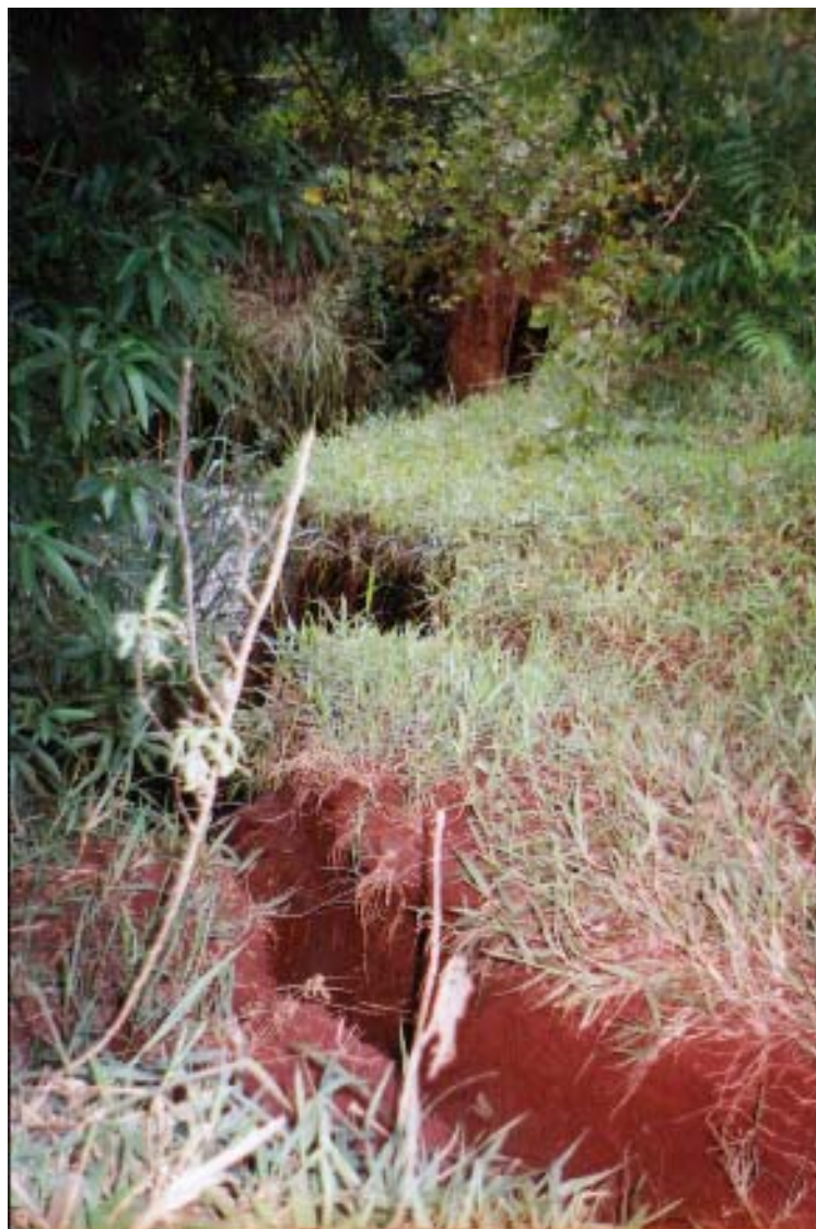
Autora: A. Perini, 2003 Mostra da área em de desbarrancamento, com ocorrência em vários pontos ao longo do curso do ribeirão Esperança.
