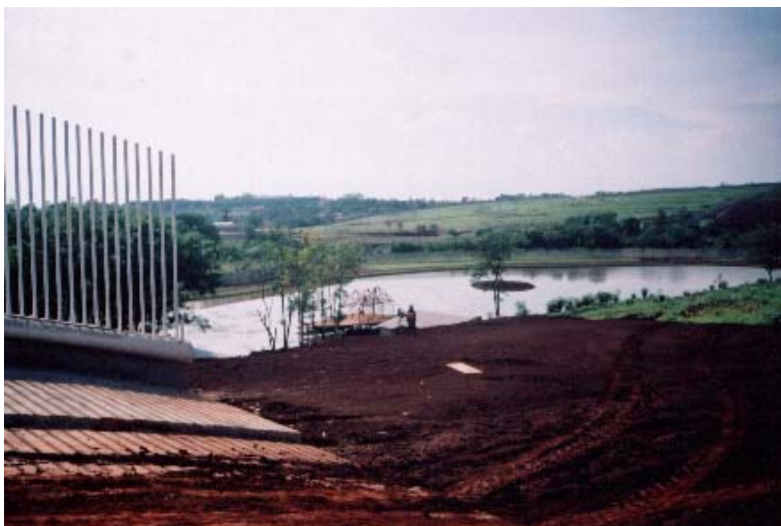
Autora: A. Perini, 2003 Obras em construção de um condomínio horizontal fechado com represamento,
