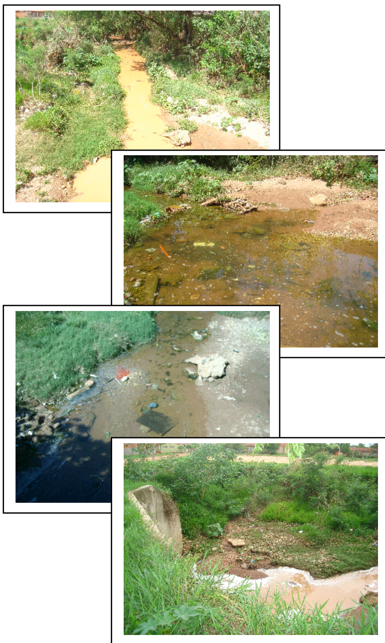
Figura 6. Final da Canalização e seu entorno.
