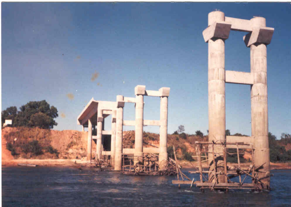
Figura 22 – Obra embargada pelo ministério público ligando a cidade de Rio do Sono à terra indígena xerente.
