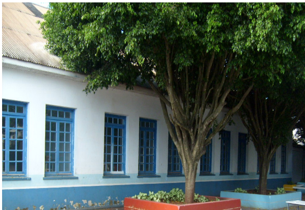
FIGURA XXIII – Fachada Lateral da Atual Escola Mace & São José 71
