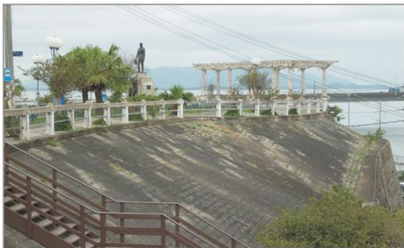
Figura 17: Limite formado pela topografia.
