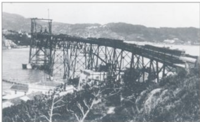
Figura 6: A construção da ponte. Fonte: acervo casa da memória
