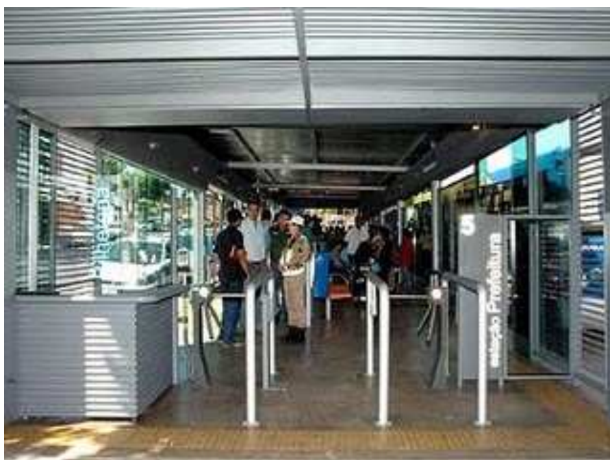
Figura 2 – Ponto de ônibus acessível FONTE: Prefeitura de Uberlândia 2009
