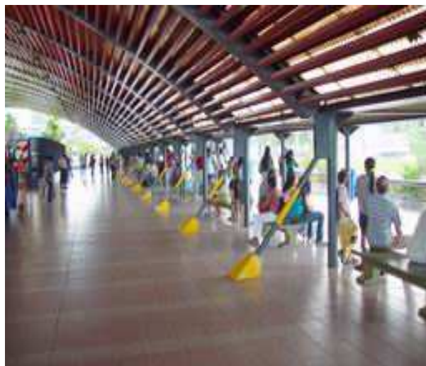
Figura 14 – Estação do Iguatemi FONTE: TRANSALVADOR 2010
