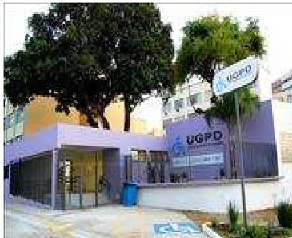
Figura 16 – Vista da fachada da UGPD. FONTE: Autora 2008
