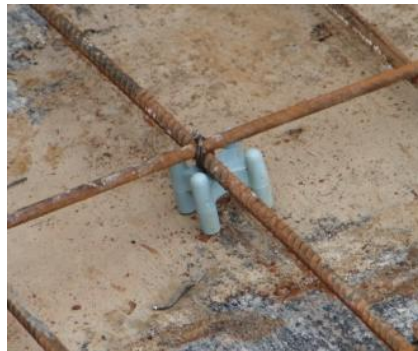
Figura 23 - Espaçador de PVC
