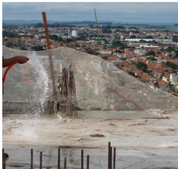
Figura 65 - Molhagem do concreto para a etapa de cura
