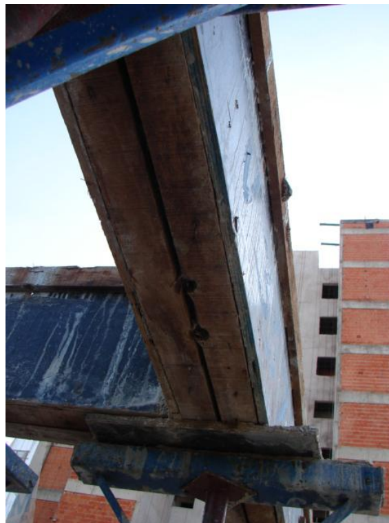
Figura 37 - Placa em 'L' para conter o concreto
