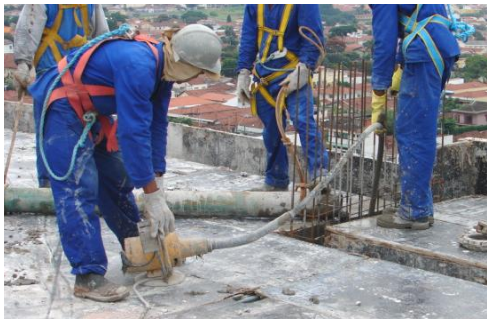
Figura 56 - Lançamento do concreto através da mangueira
