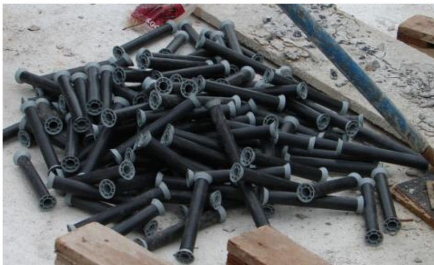
Figura 8 - Tubos e cones de encosto
