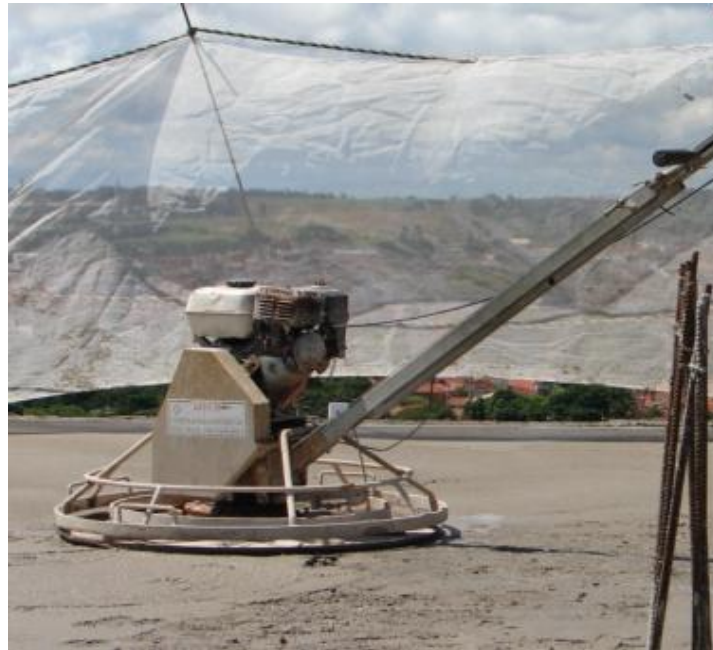
Figura 64 - Alisamento da superfície da laje
