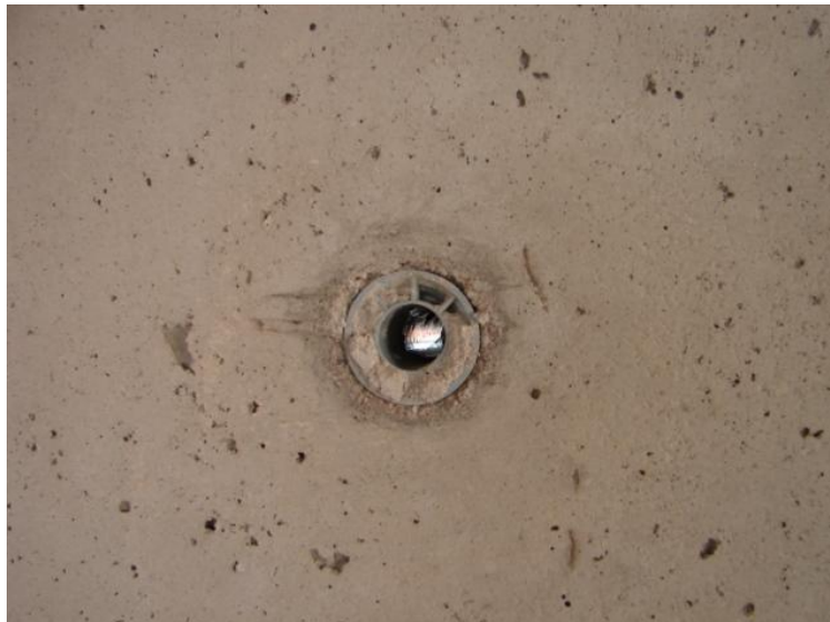
Figura 33 - Tubo cilíndrico concretado no pilar
