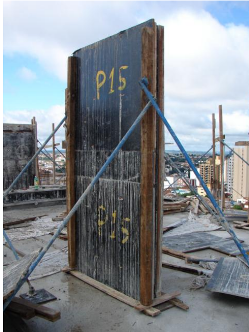
Figura 30 - Fôrma de pilar numerada e devidamente aprumada
