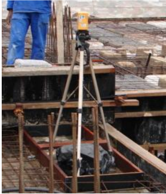
Figura 49 - Aparelho usado para conferência de nível da laje
