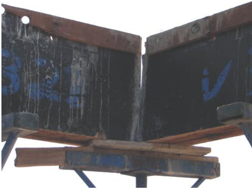
Figura 35 - Madeira de suporte para evitar o escoamento excessivo do concreto
