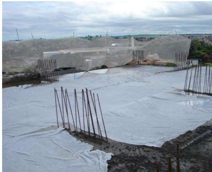
Figura 66 - Mantas para evitar a evaporação excessiva e brusca da água do concreto
