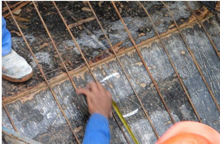
Figura 45 - Medição para o posicionamento adequado das barras da escada
