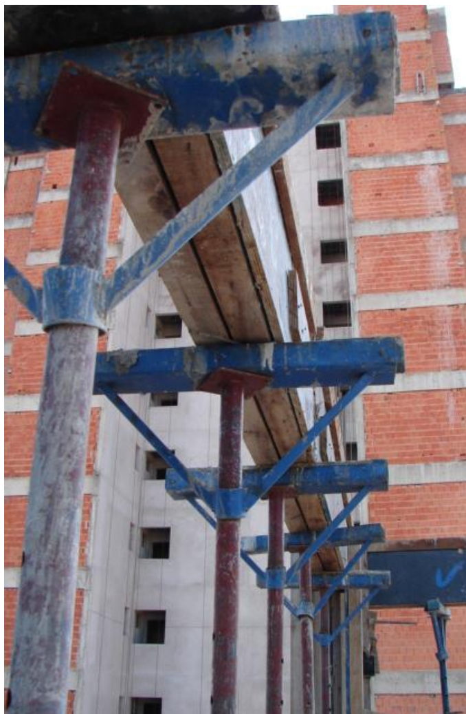
Figura 34 - Escoras e madeiramento das vigas
