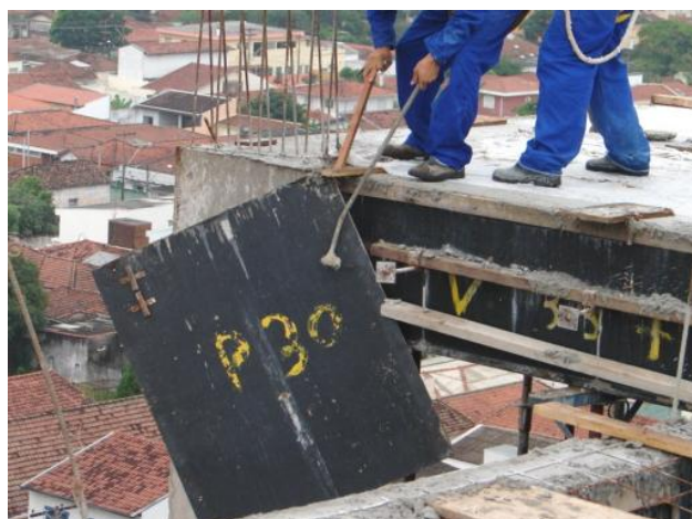
Figura 69 - Uso de martelo para remoção de fôrmas dos pilares
