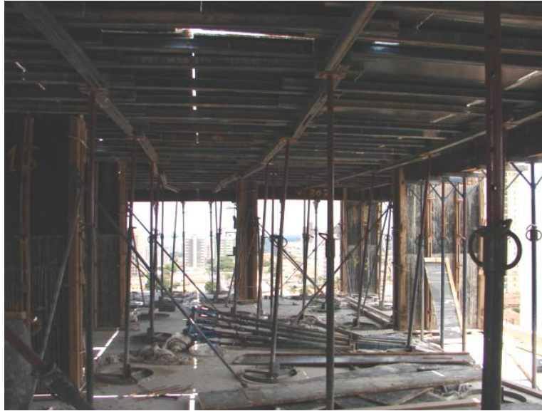
Figura 40 - Escoras, barras de suporte e fôrmas das lajes
