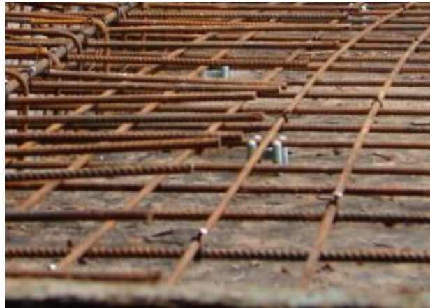
Figura 9- Espaçador do tipo pino
