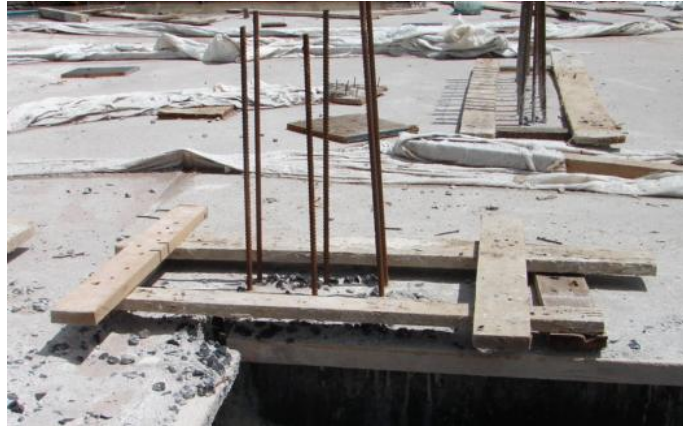
Figura 28 - Base do pilar (gastalho)
