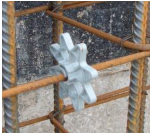
Figura 7 - Espaçador circular
