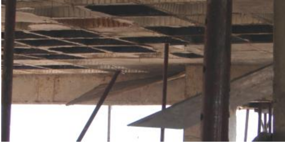
Figura 68 - Uso de barras para remoção de fôrmas
