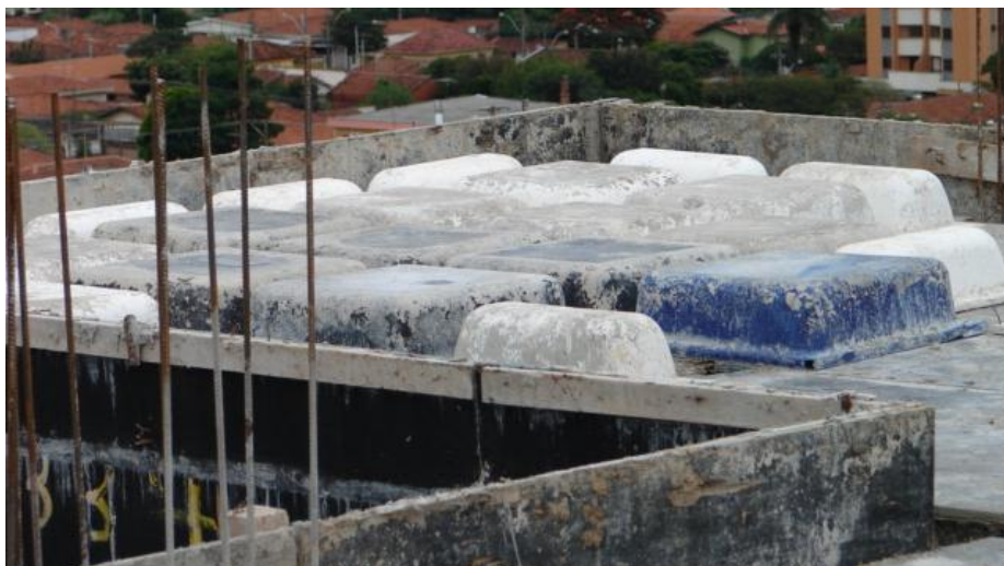
Figura 41 - Revestimento que servirá de nervura para a laje
