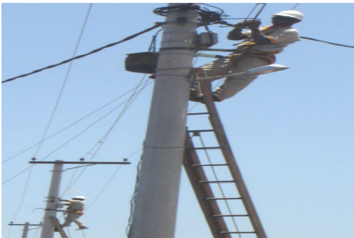
Figura 12 – Serviço de construção de rede Fonte: Fonte: www.intranetempresaWZ.com.br
