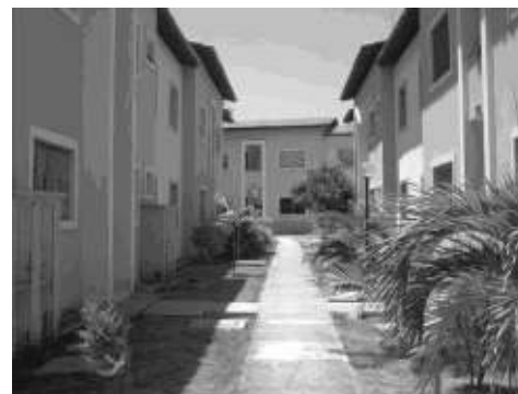
Figura 4. Fachada dos blocos
