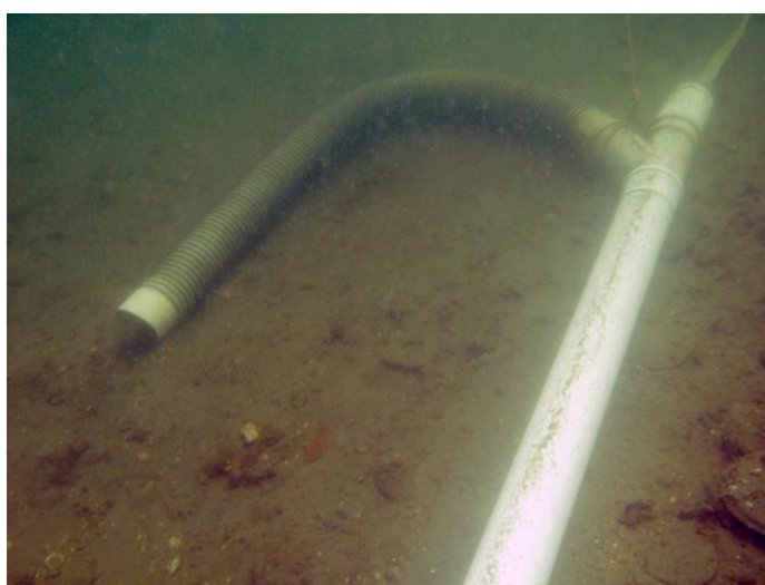
Imagem 74 - Conexão em “Y” da sugadora
