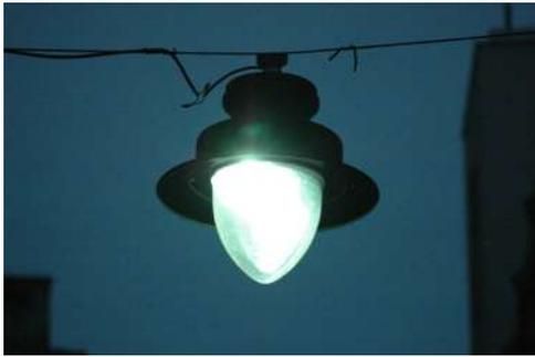
A nova luminária durante a noite: a luz é toda orientada para baixo, porém sem controle de intensidade nos ângulos limites para evitar ofuscamento.
