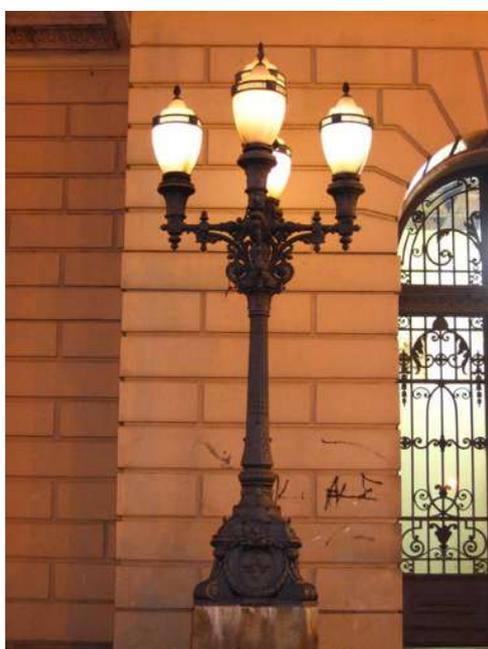
O poste em ferro fundido equipado com lâmpadas de vapor de mercúrio. O alto brilho concentrado numa pequena superfície de difusão causa ofuscamento.
