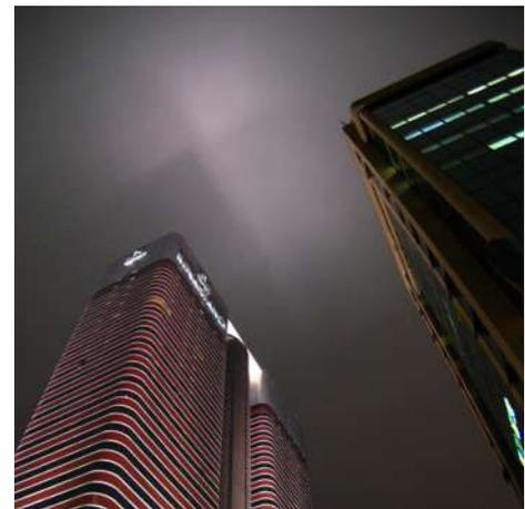
Apesar da alta intensidade dos projetores indiretos, o destaque do edifício é limitado, principalmente, devido à baixa refletância dos materiais de sua fachada. Nota-se a grande quantidade de luz que incide nas nuvens, ocasionando o efeito de céu luminoso, comprometendo o bem-estar na cidade e o meio ambiente.
