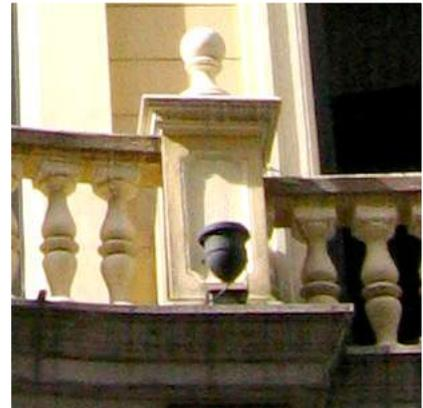
Ao todo são 4 projetores fixados do lado externo do balcão e mais 8, divididos em pares, em cada pavimento do edifício. Como a arcada dos pavimentos superiores não foi contemplada de maneira contínua, o efeito ficou defasado.
