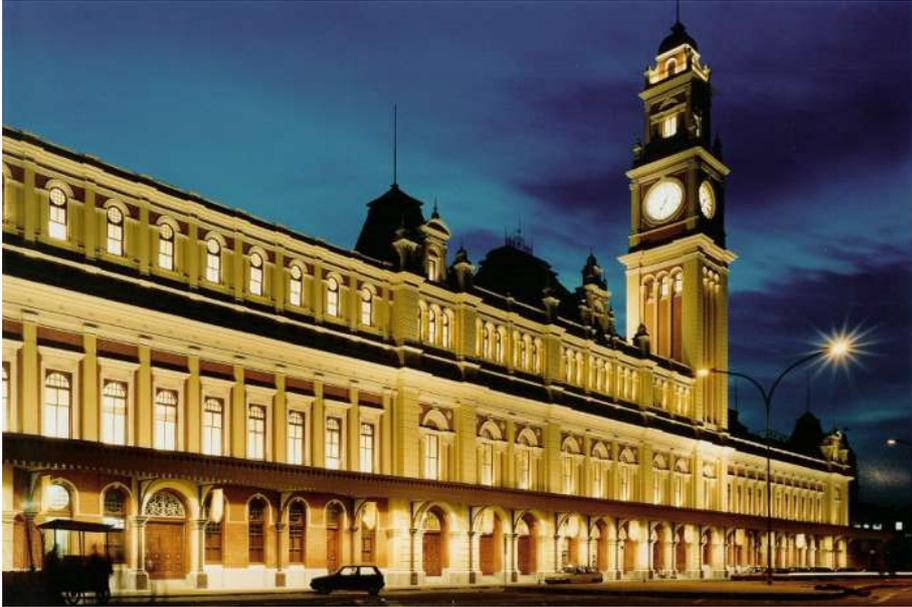
A horizontalidade do edifício foi valorizada devido à solução de iluminação contínua, com projetores instalados acima e abaixo da marquise. Os elementos verticais foram fragmentados, auxiliando essa interpretação. A imagem não é rebuscada, favorecendo o seu alto grau de legibilidade. (Fonte: Franco & Fortes)
