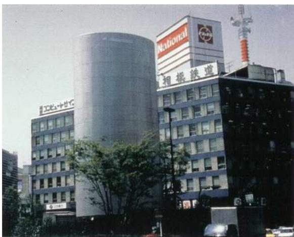
A Torre dos Ventos projetada por Toyo Ito em Kanagawa (Japão, 1986) e iluminada por Karou Mende é um exemplo de projeto em que foi utilizada luz dinâmica. Durante o dia parece uma estrutura sólida, porém à noite ela se desfaz e cresce novamente dependendo de como é iluminada (abaixo). A luz se altera de acordo com a velocidade que o vento incide em sua superfície e, também, com o nível de ruído do entorno, que são medidos por sensores controlados por computador. (Fonte: MENDE, 2000)
