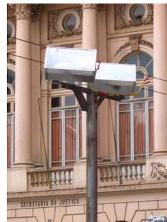
Ao todo são 4 projetores alojados em 2 postes à frente do edifício. Nota-se a inexistência de alojamentos para os reatores no conjunto, por isso supõe-se que as lâmpadas sejam de tecnologia mista. Como estão próximos da fachada e seu refletor não é compatível com a geometria do edifício, a luz contempla em maior parte os primeiros andares, produzindo efeito defasado.
