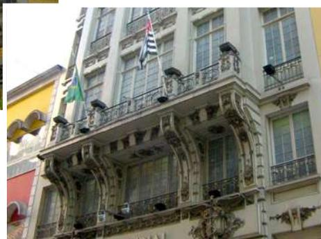
Devido à projeção de luz na fachada acima do balcão ser bem rasante à esta superfície, o grau de contraste definido cria uma impressão de sofisticação coerente com a importância do edifício. Contudo, o impacto na poluição luminosa é demasiadamente alto, causado principalmente pela falta de controle na emissão de
