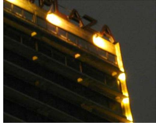
Fachada principal iluminada por projetores nas laterais e na viga da cobertura. Os projetores não contemplam a linearidade da arquitetura e produzem efeito defasado, comprometida ainda mais pela escolha equivocada da lâmpada, que distorce suas cores.
