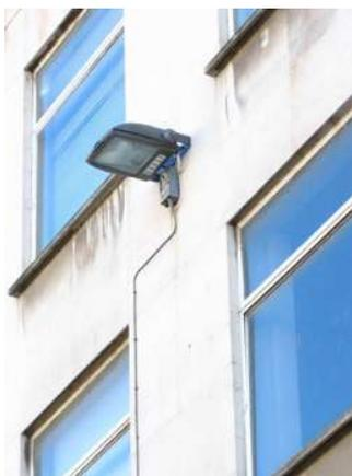
Luminária assimétrica instalada ao longo dos calçadões do centro de Liverpool (Inglaterra).
