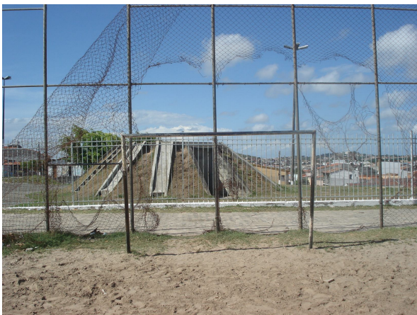
Figura 77: Péssimo estado da Quadra Esportiva Fonte: Silva, C. F. R da - Pesquisa de Campo, 2009
