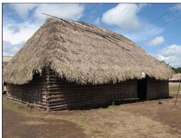
Figura 291 Exemplo de uma casa de Pau a pique na aldeia Kururuzinho (Foto: Stuchi 2007).
