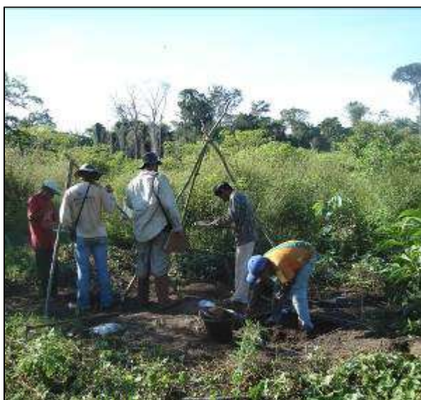
Figura 229 Área de escavação do Poço Teste 01.
