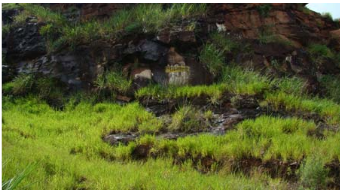
Figura 60 - Parte mais escura decorrente do fluxo de água pelas descontinuidades horizontalizadas.
