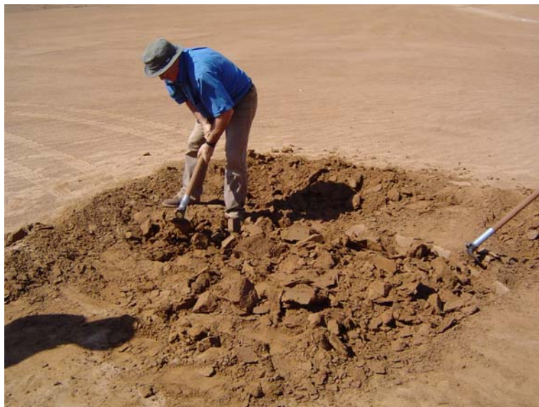
Figura 98 – Abertura da trincheira em solo compactado.
