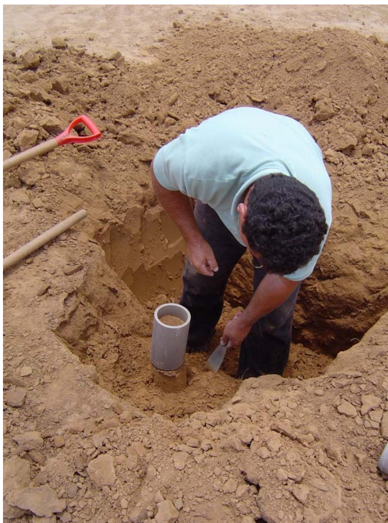
Figura 36 – Extração de amostras em trincheira escavada.
