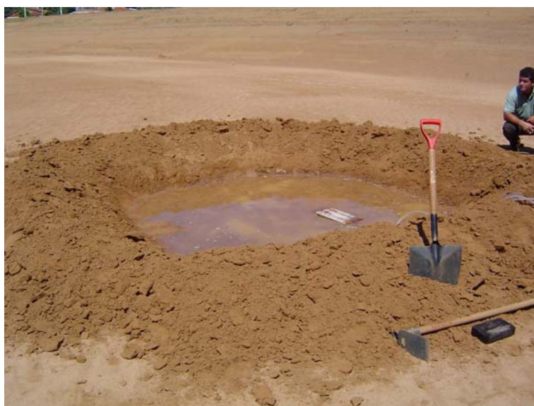
Figura 99 – Perfil instantâneo: ensaio em andamento – infiltração em trincheira.
