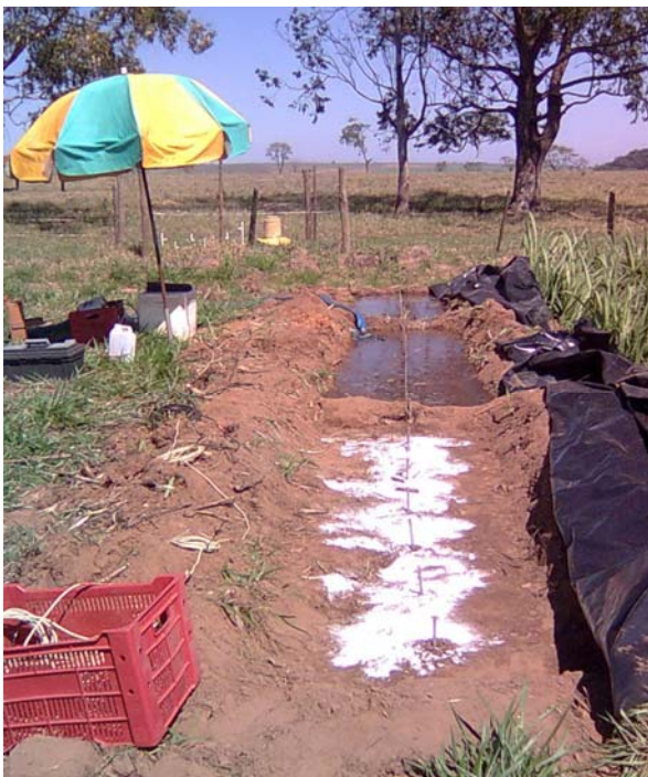
Figura 140 – Detalhe do espalhamento do NaCl no interior da trincheira.
