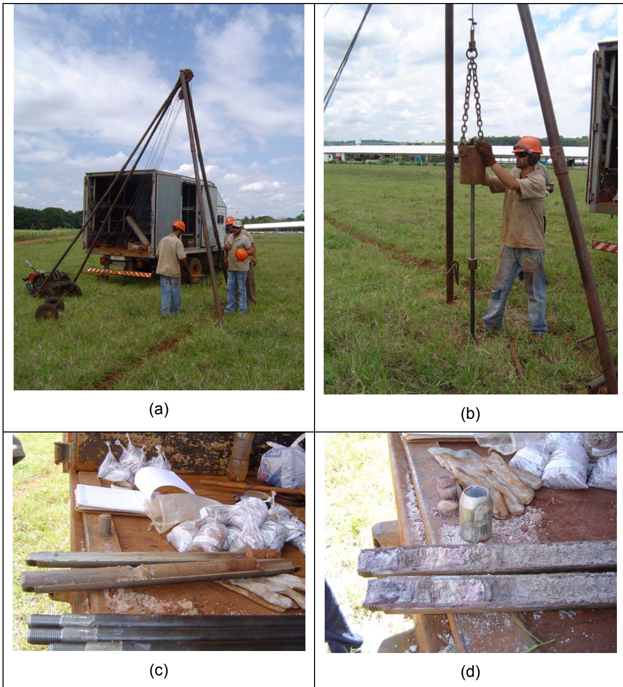
Figura 121 – (a) montagem do equipamento; (b) execução da sondagem – percussão; (c) amostras retiradas; (d) detalhe da textura arenosa dos materiais.
