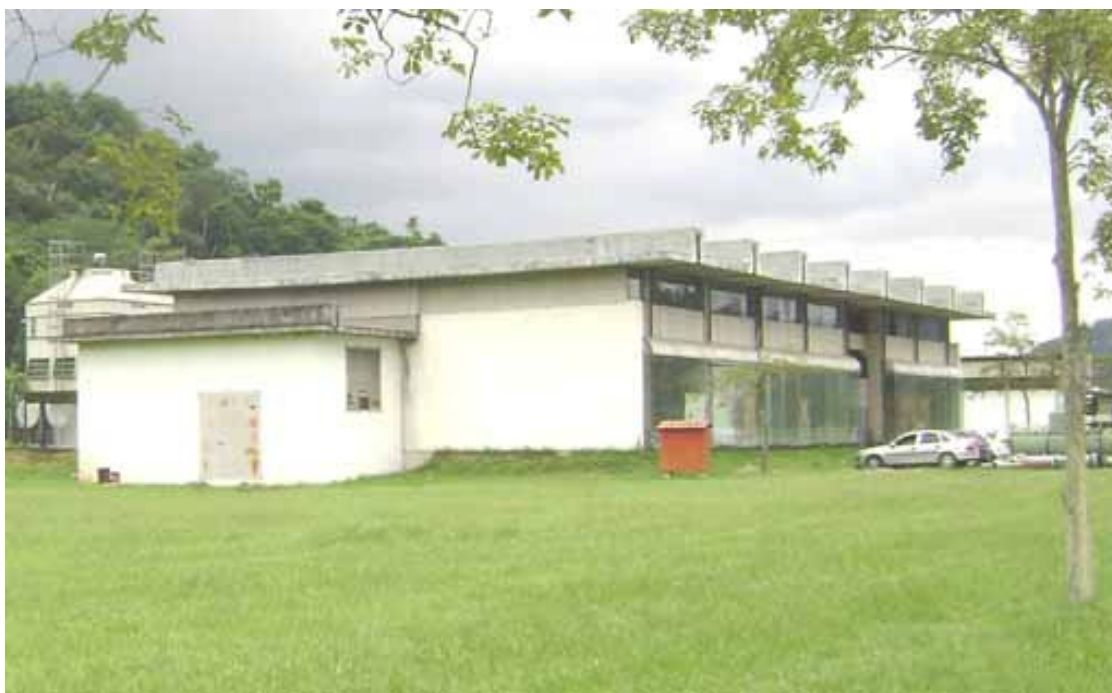
Figura 16 - Central de produção de água gelada do sistema de climatização
