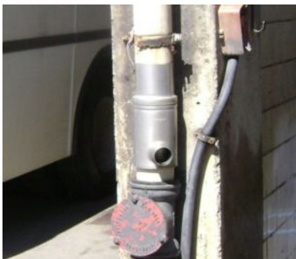
Figura 12 - Filtro para instalação de aproveitamento de água de chuva
