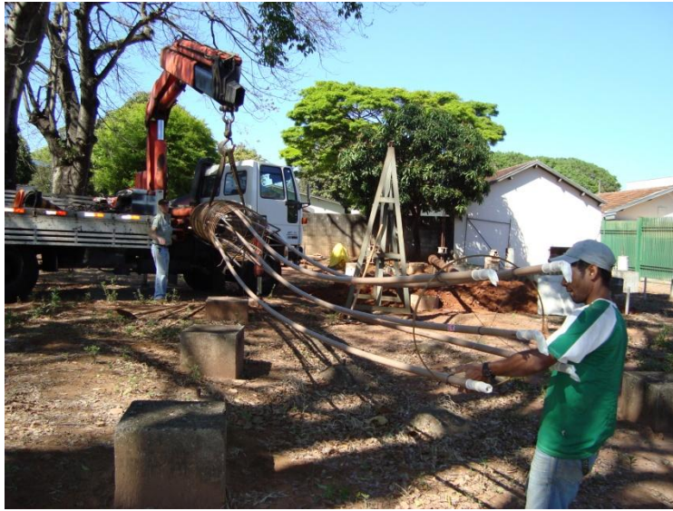
Figura 4.11 – Armação das estacas com tubo de PVC comum
