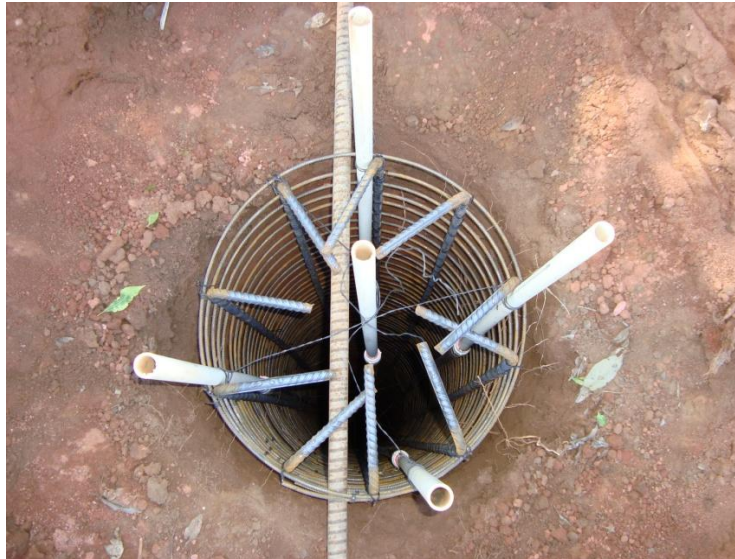
Figura 4.12 – Armação das estacas posicionada na cava com PVC especial nas pontas
