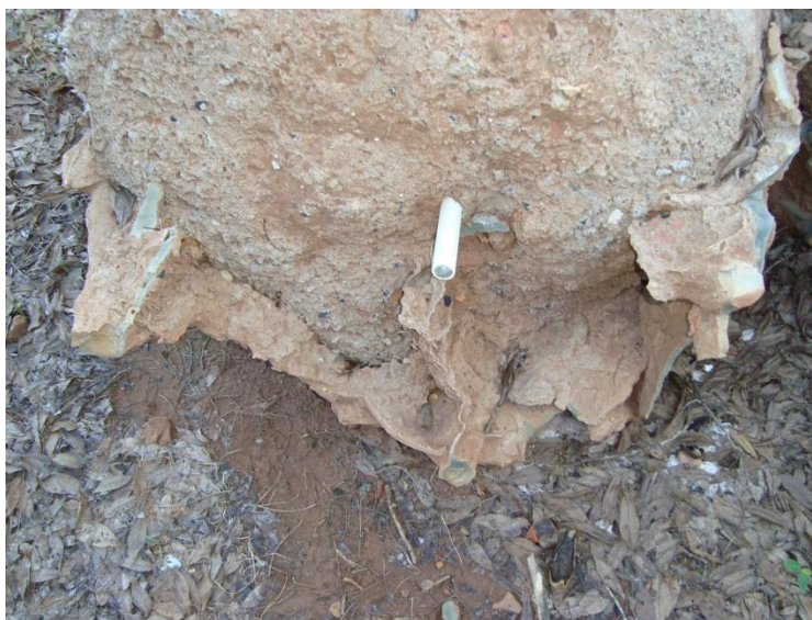
Figura 6.14 – Aumento do diâmetro do cilindro promovido pela injeção de calda (a)
