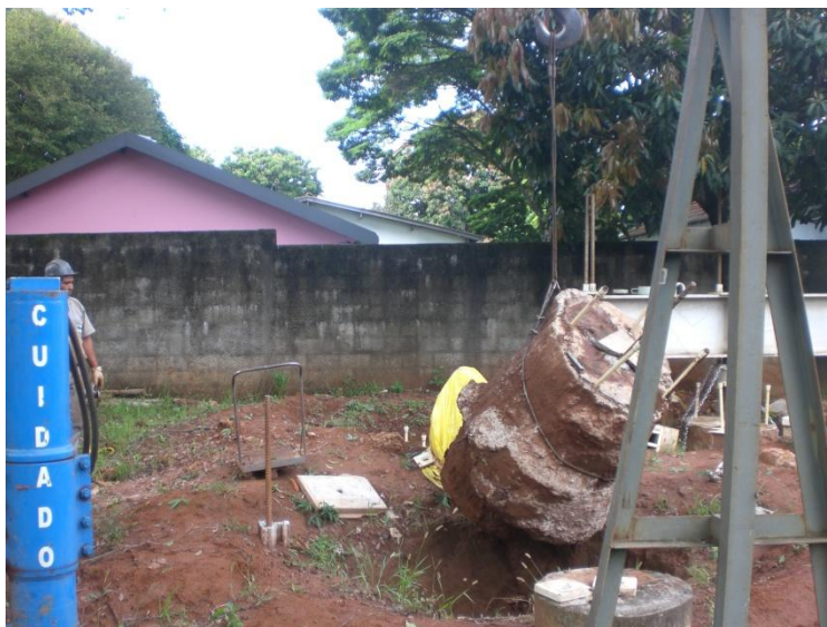
Figura 4.31 – Extração do cilindro com guindaste (a)
