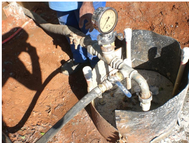
Figura 4.13 – Execução da injeção
