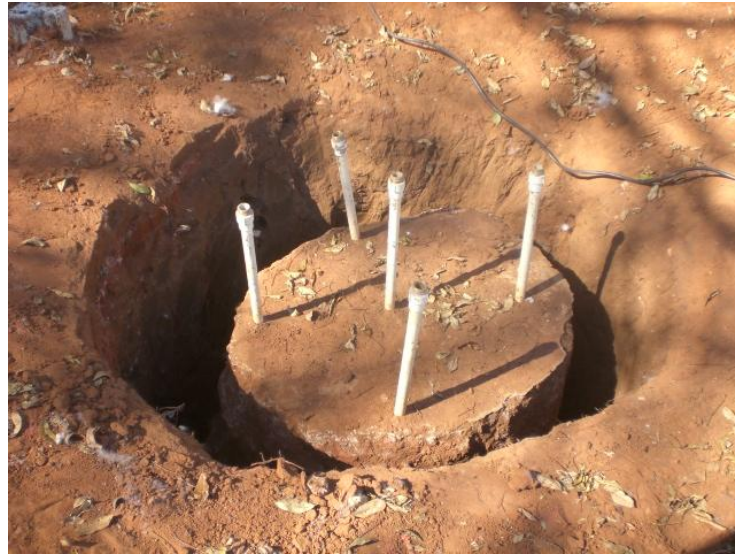
Figura 4.19 – Cilindro de concreto após remoção do solo lateral
