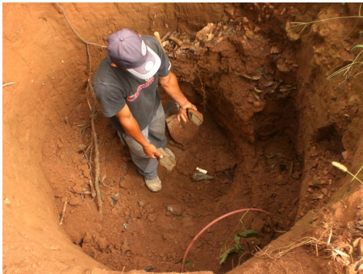
Figura 6.9 – Pedacos de calda no fundo da cava após extração do cilindro
