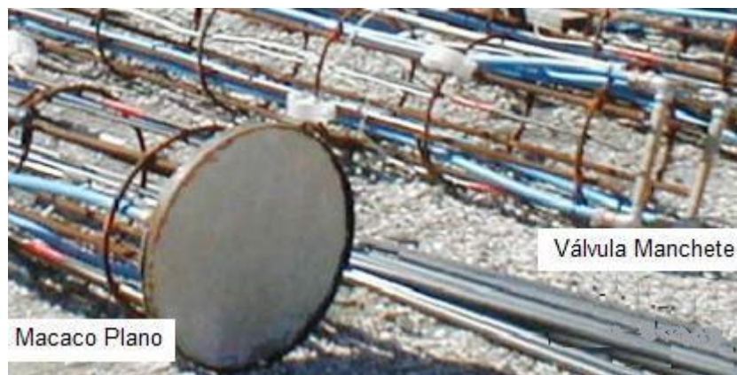
Figura 2.9 – Armação das estacas com macaco hidráulico plano e válvulas manchete para realização das injeções (Dapp et al. , 2006)
