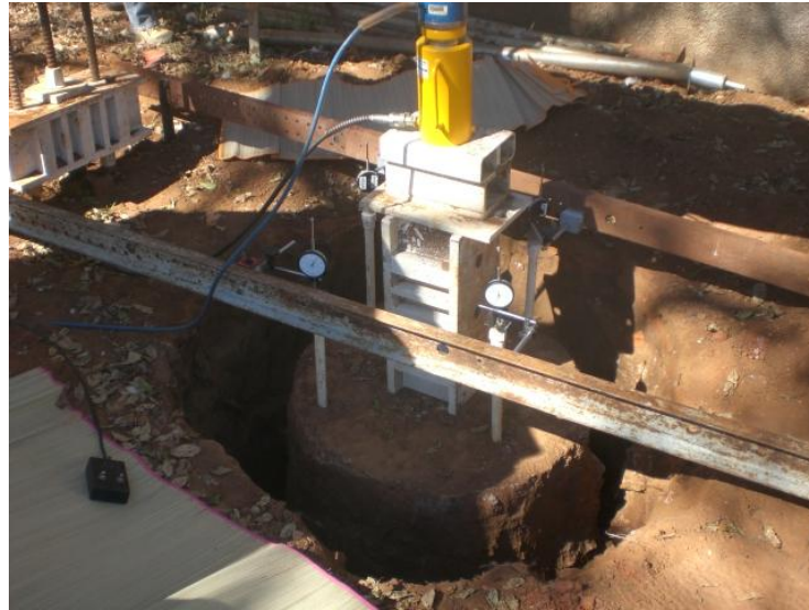
Figura 4.21 – Detalhe da prova de carga estática: cilindro de concreto com solo lateral removido
