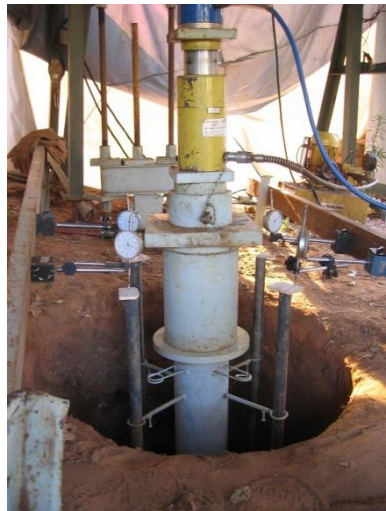
Figura 4.25 – Montagem da prova de carga estática
