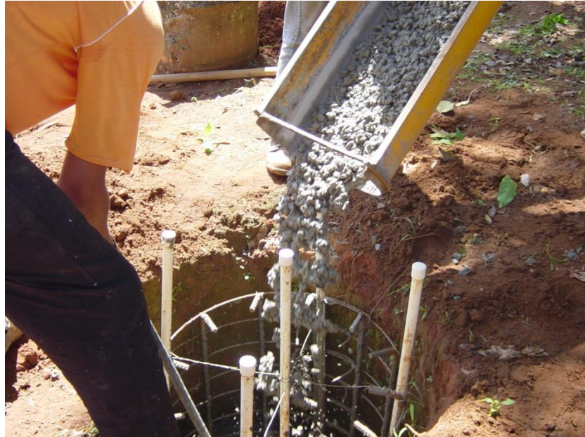
Figura 4.3 – Concretagem
