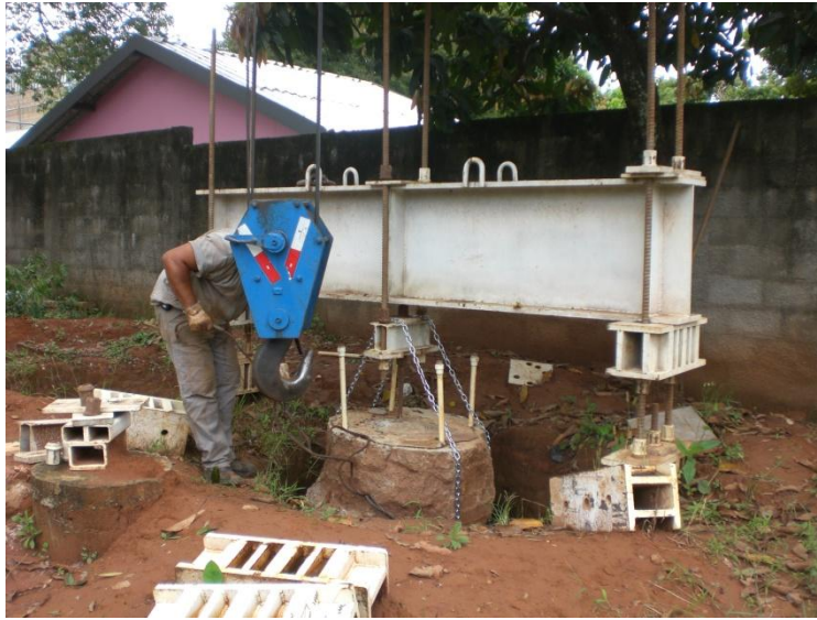
Figura 4.30 – Tentativa de extração com pórtico de reação
