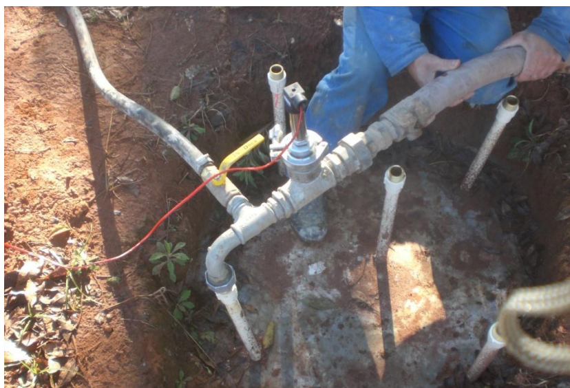
Figura 4.5 – Execução da injeção
