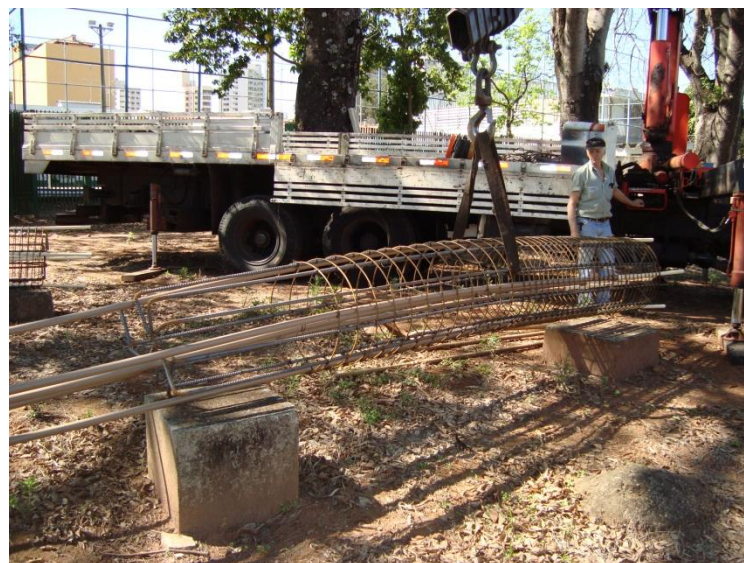
Figura 4.10 – Armação das estacas com tubos de PVC
