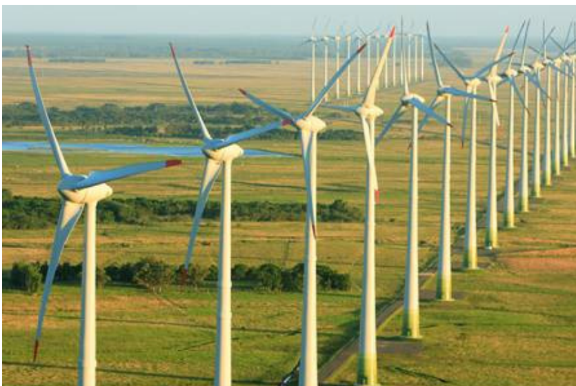
Figura 57 – Parque Eólico de Osório - Osório – RS Fonte: Aguiar e Piratini (2007)
