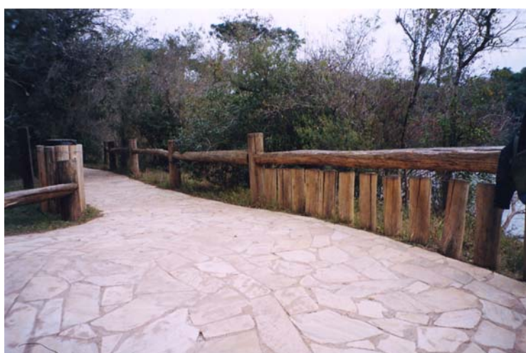
Fotografia 14 – Trilha de Caminhada com Revestimento de Placas de Quartzito – Parque Estadual de Vila Velha – Município de Ponta Grossa - Paraná – Fonte: o autor
