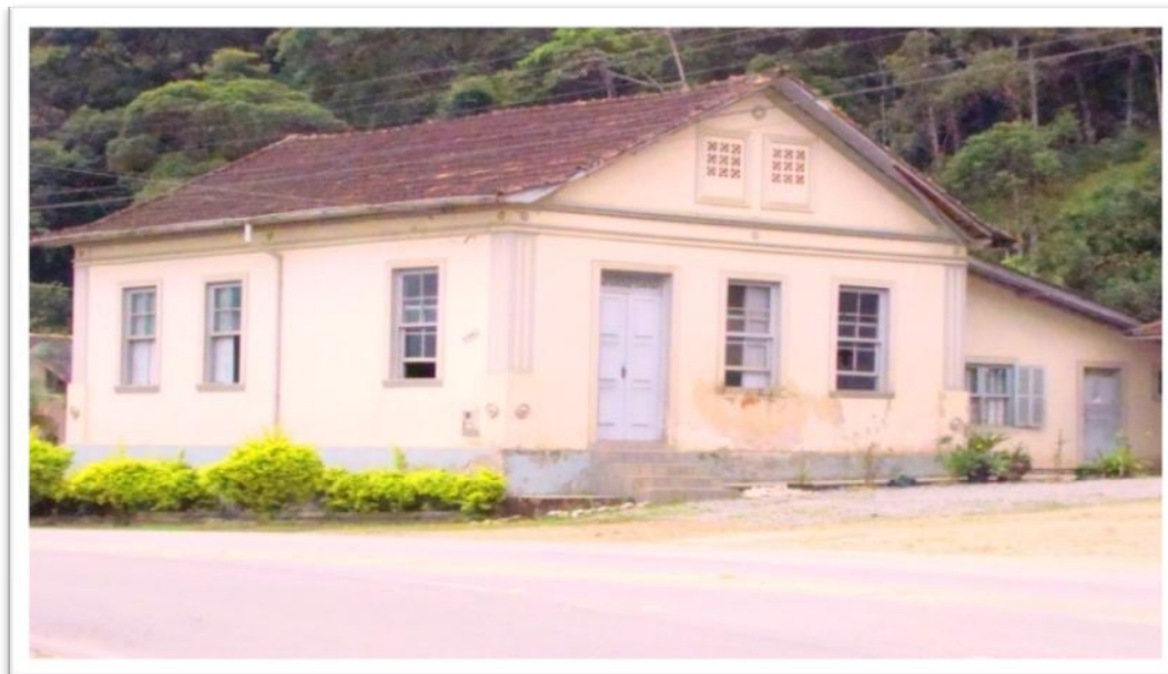
Figura 4: Casa Centenária que Passou por Reforma, 2009 Fonte: Brotar e Crescer (2009).
