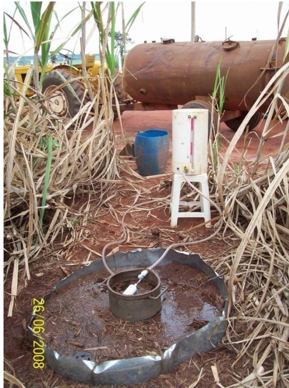
Figura 52 – Equipamento usado no ensaio de infiltração em materiais residuais argilosos provenientes da Formação Serra Geral
