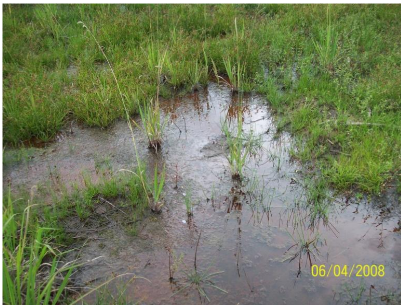
Figura 65 – Acúmulo de água em superfície gerado pelas difrações hídras.
