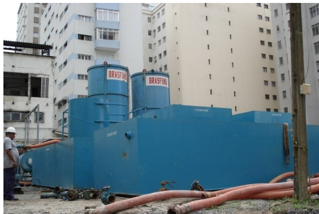
Fotografia 1 - Central típica de polímeros Fonte: Elaborado pela autora (2007)
