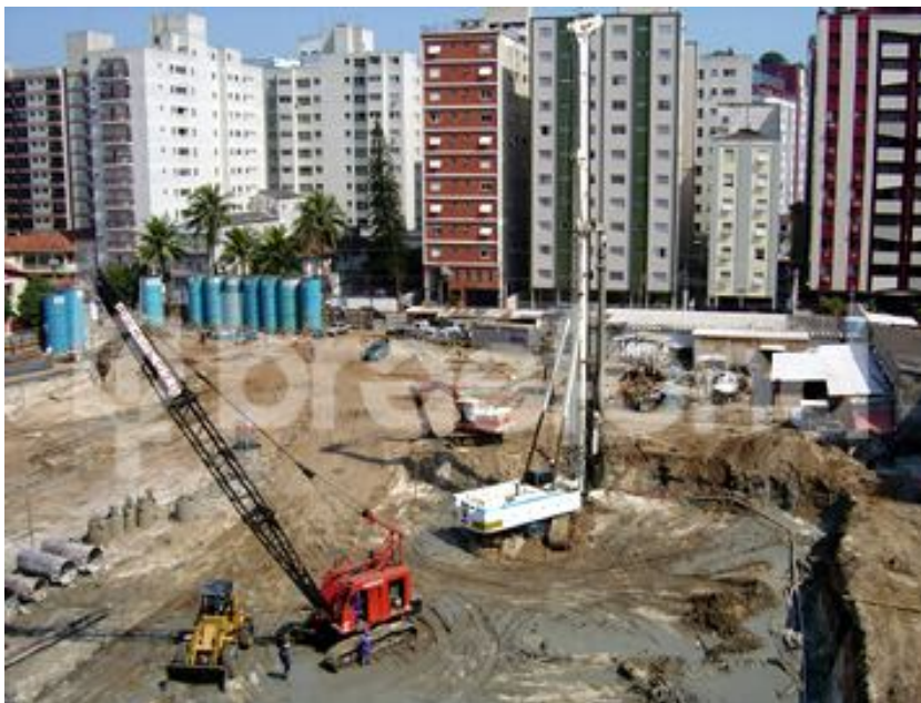
Fotografia 10 – obra de lama bentonítica (site Brasfond)
