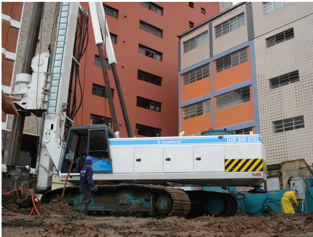
Fotografia 8 – Execução de estacas com a Perfuratriz Mait HR 300 Fonte: Elaborado pela autora (2008)
