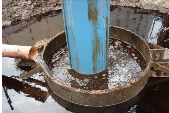
Fotografia 5 - Escavação com auxílio de polímero junto ao furo Fonte: Elaborado pela autora (2007)
