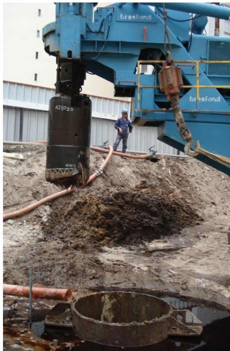
Fotografia 6 - Equipamento de escavação retirando o material escavado Fonte: elaborado pela autora (2007)
