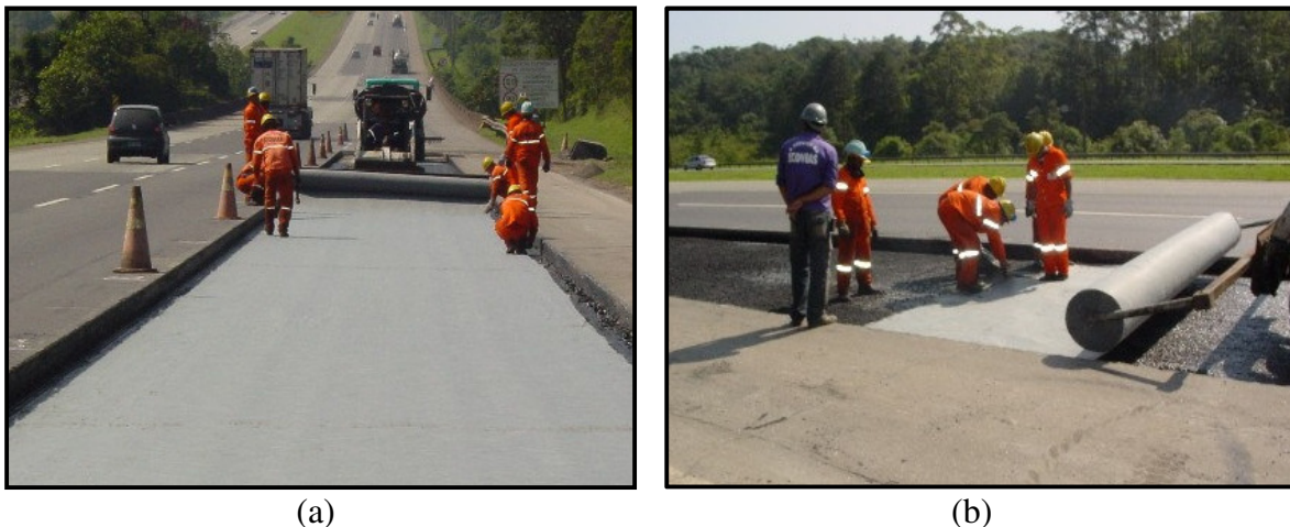
Figura 2.13 – Instalação do geotêxtil: (a) Instalação com equipamento específico e (b) Detalhe do rolo entre as imprimações (BIDIM, 2005).
