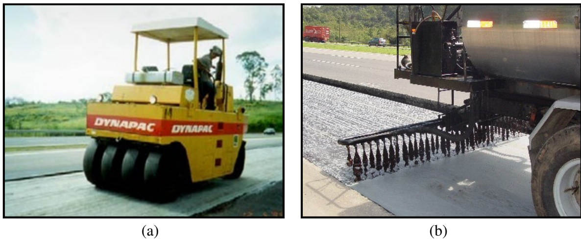
Figura 2.14 – Sequência de operações: (a) Compactação com rolo pneumático e (b) Aplicação da segunda taxa de ligante (Vilchez, 2002; BIDIM, 2005).
