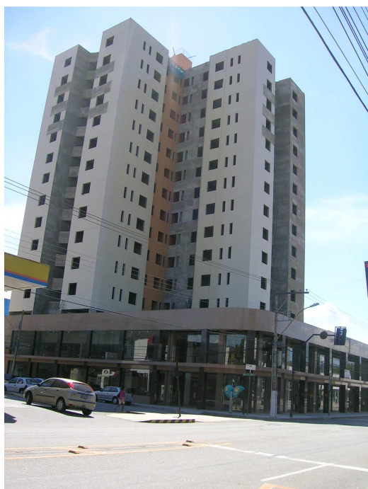
FIGURA 13 - Prédio na Av. Brasil, Bairro Iguazu - Ipatinga Fonte: Arquivo particular da autora, 2010.
