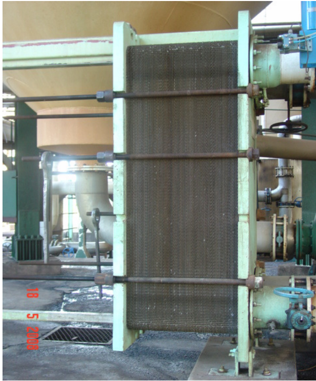
Figura 2.10. Foto do Trocador de Calor de Uma das Dornas da V.O.- Unidade Catanduva.
