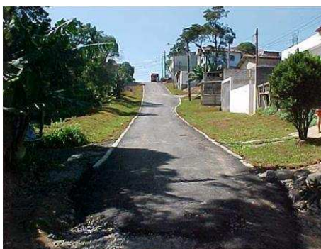
Foto 35 - Calçadas permeáveis do Parque Andreense após obras previstas no TAC
