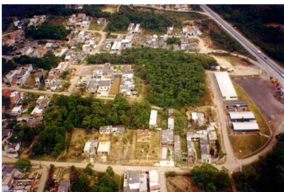
Foto 17 – Vista aérea do Parque Andreense antes do início das obras do Projeto GEPAM
