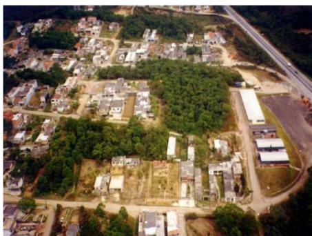
Foto 34 -: Vista área do Parque Andreense antes das obras do TAC
