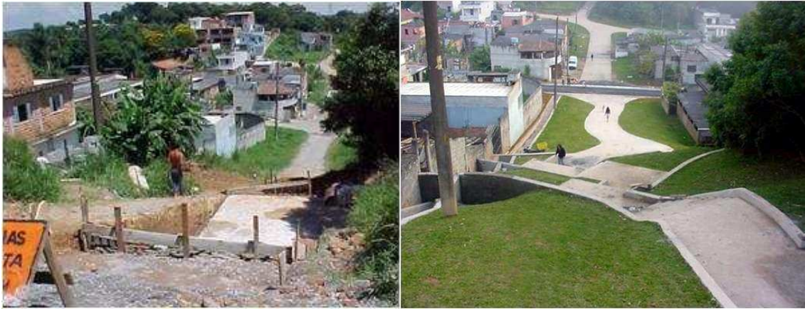
Fotos 19 e 20 - Evolução das obras na Escadaria Jandaia
