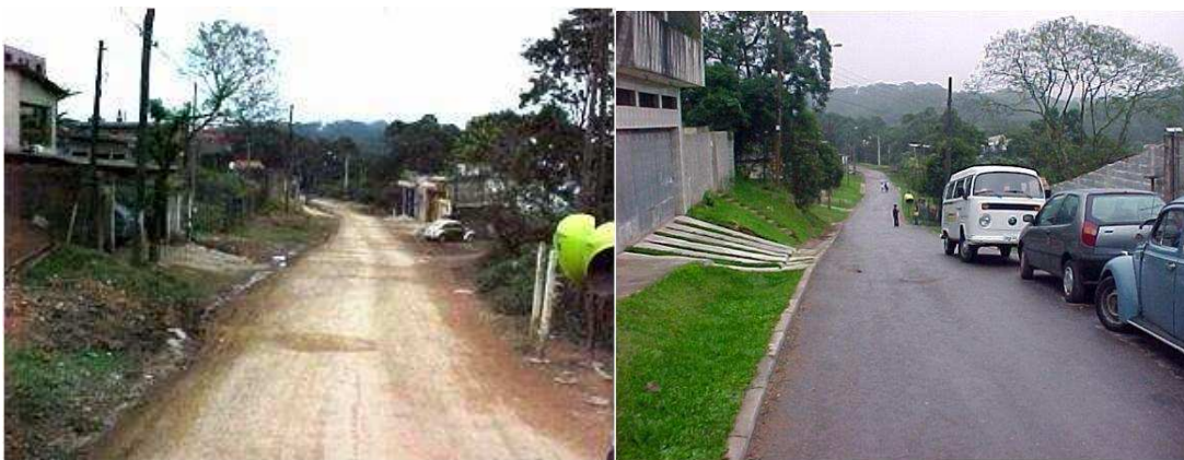
Fotos 23 e 24 - Evolução das obras na Rua Mandaguari
