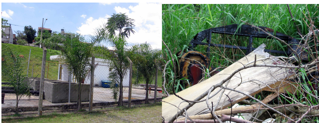
Foto 10- ETE Estação de Tratamento de Esgoto do Jardim Pinheiro em vistoria realizada em fevereiro de 2009
