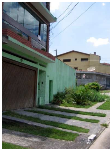
Foto 36 - Calçadas permeáveis do Jardim Pinheiro após obras previstas no TAC
