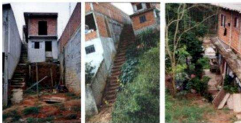
Fotos 25,26 e 27 - Construções típicas do Sítio Joaquina em área de risco
