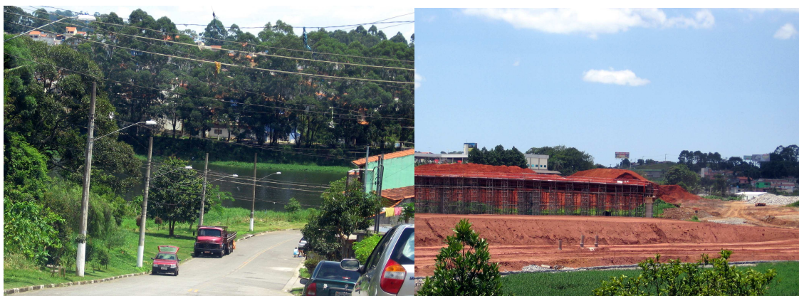
Foto 6 – Vista da Rua Guaira e da represa ao fundo em vistoria realizada em fevereiro de 2009.
