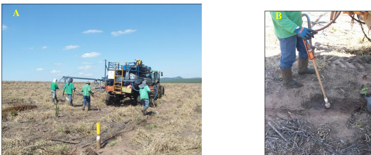
Figura 6. A: Irrigação com tanque e mangueiras de irrigação. B: Válvulas manuais.
