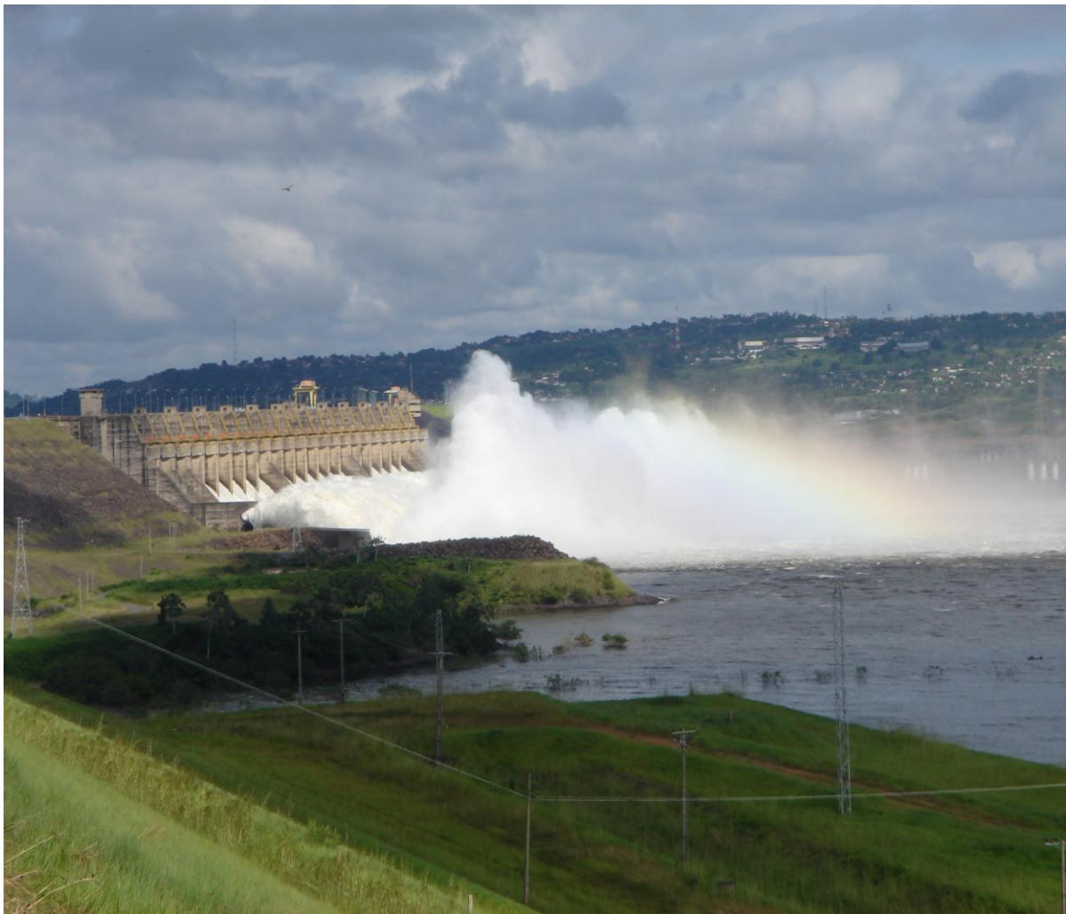
Figura 1. Usina hidrelétrica de Tucuruí
