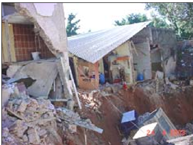
Fotografia 14 - Vista dos fundos dos imóveis nº 5 e 25. Fonte: IPT, 2003.
