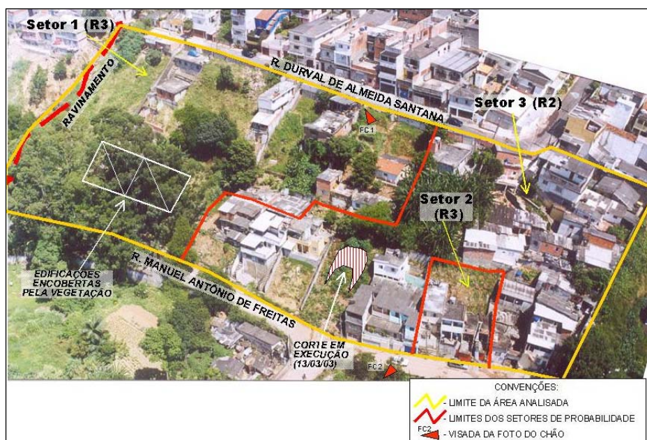
Fotografia 1: Vista do Talude e os setores de riscos. Fonte: IPT, 2003.
