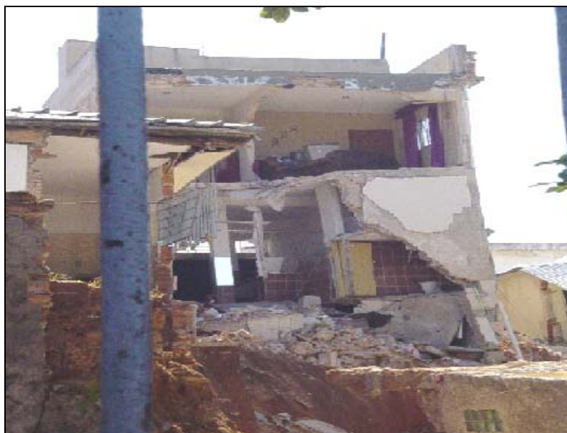
Fotografia 13 - Vista dos fundos do imóvel nº 31 da Rua Zezé Leone. Fonte: SABESP, 2003b.
