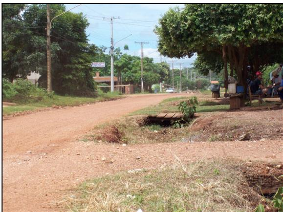
**FIGURA 4.20** Rua da cidade de Bonito – Falta galeria de águas fluviais, pavimentação, guias de sarjeta e calçadas
