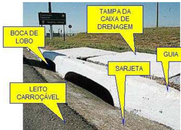
Figura 3.5: Sistema convencional de drenagem urbana e alguns de seus componentes. Fonte: Watanabe, s.d.
