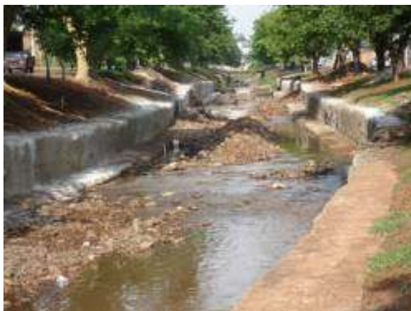
Figura 3.6: Canal com sistema de gabião no Córrego Prosa. Fonte: Carrilho, 2009.
