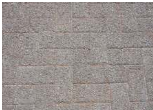
Figura 4.22: Concreto poroso Fonte: Martins, 2006.
