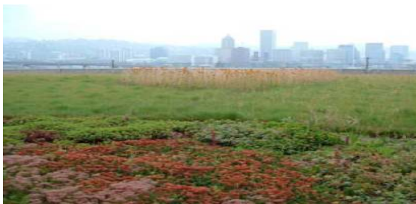
Figura 3.13: Cobertura verde no edifício Multnomah County , Portland, Oregon. Fonte: fotografia de Erica Guttman.
