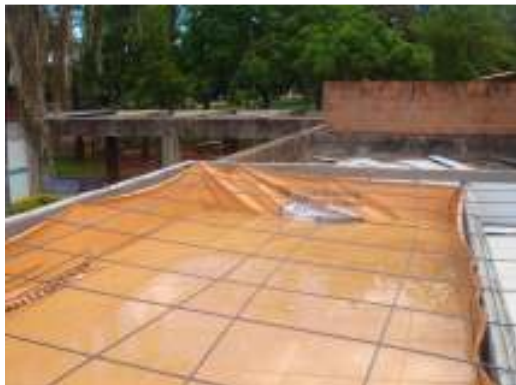
Figuras 4.6 e 4.7: Reservatório com lona em fase de montagem e após a montagem.
