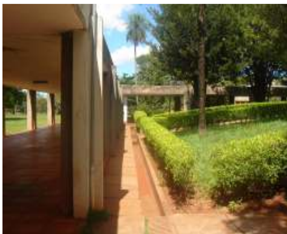
Figura 4.16: Canaletas para onde são escoadas as águas do estacionamento. Fonte: Autora.
