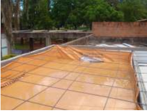
Figuras 4.6 e 4.7: Reservatório com lona em fase de montagem e após a montagem. Fonte: autora.
