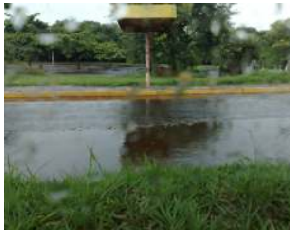
Figura 4.17: Foto de área da pista parcialmente alagada. A vista é do estacionamento do Glauce Rocha. Fonte: Autora.
