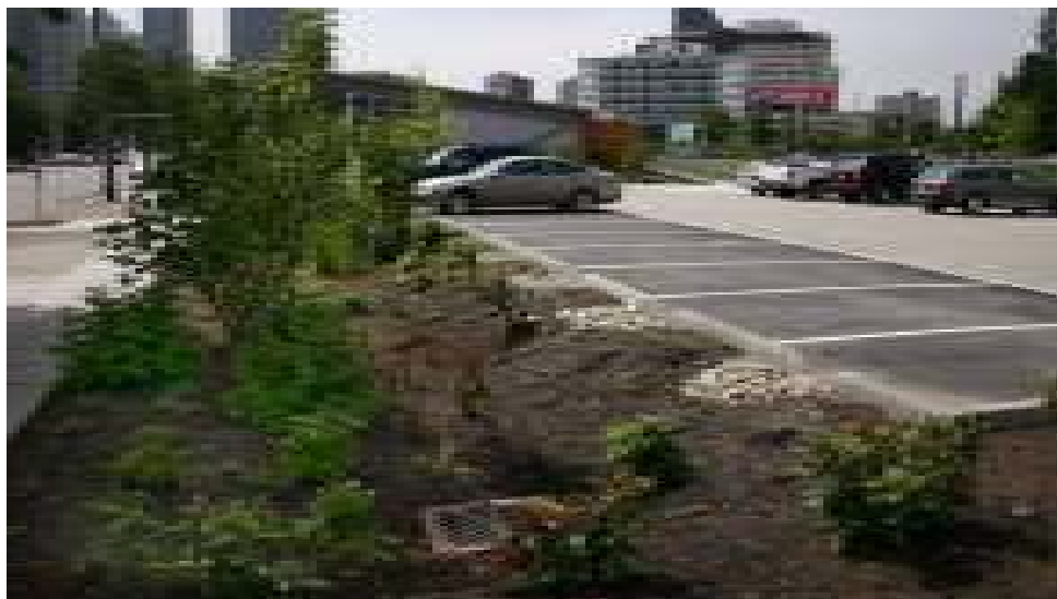
Figura 3.11: Típico sistema de bio-retenção Fonte: South Lake Union Discovery Center , 1993.
