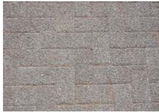
Figura 4.22: Concreto poroso Fonte: Martins, 2006.
