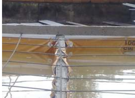
Figura 4.9: Os extravasores dos reservatórios Fonte: autora.
