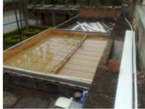
Figuras 4.6 e 4.7: Reservatório com lona em fase de montagem e após a montagem. Fonte: autora.
