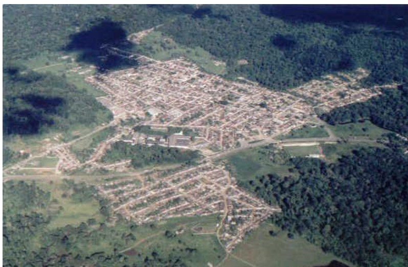
Figura 3.2 - Vista área da cidade de Buerarema
