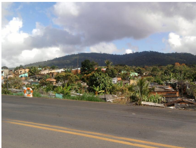
Figura 3.7 – Rodovia próxima ao setor 03
