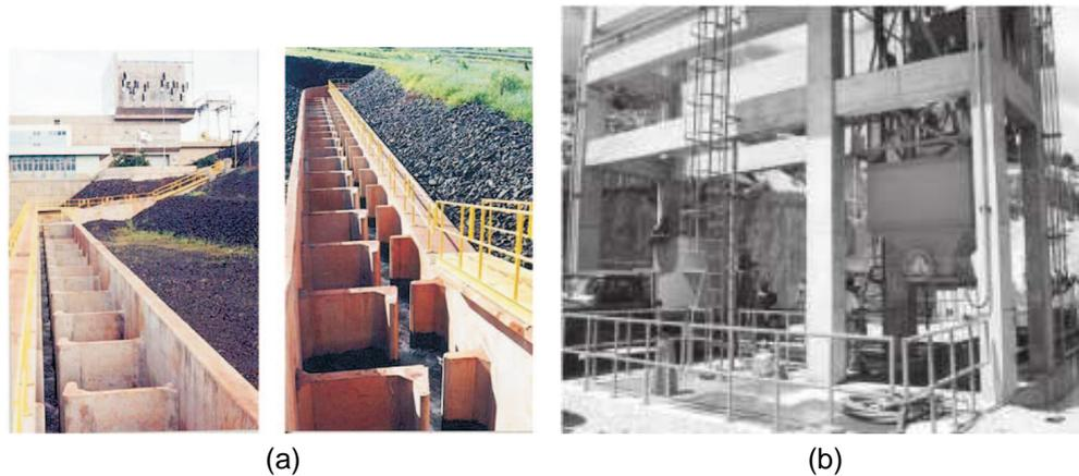
Figura 1.3: (a) Mecanismo de transposição de peixes existente na barragem hidrelétrica de Igarapava em Minas Gerais, Brasil; (b) Elevador de peixes da Usina de Santa Clara em Minas Gerais, Brasil.
