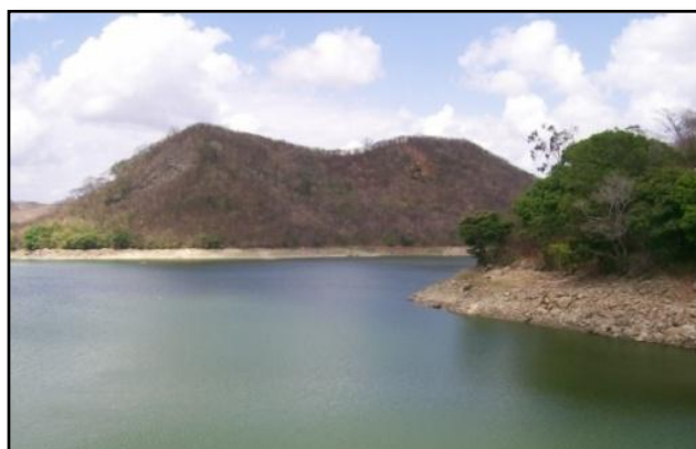
Figura 14: Vista parcial do açude Acarape do Meio
