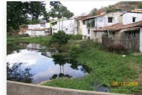
Figura 07: ocupação desordenada da planície de inundação.
