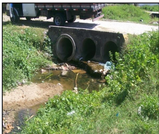
Figura 41: canalização de um afluente do rio Pacoti, contribuindo para alterações na geometria do canal
