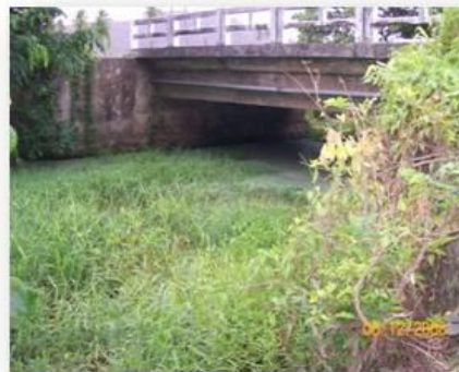
Figura 04: Canalização de afluentes.
