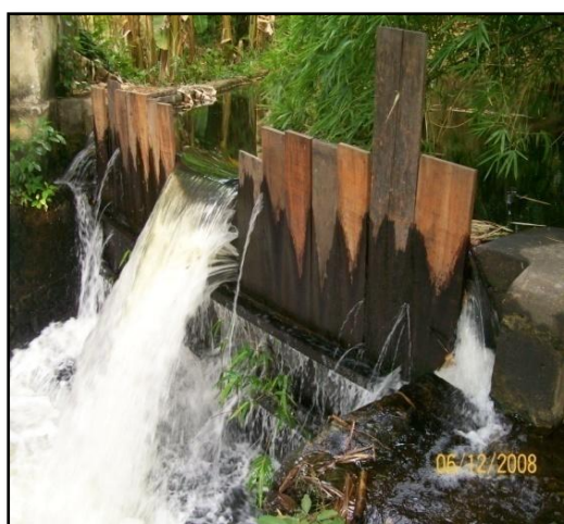
Figura 39: barramento no canal principal do rio Pacoti;
