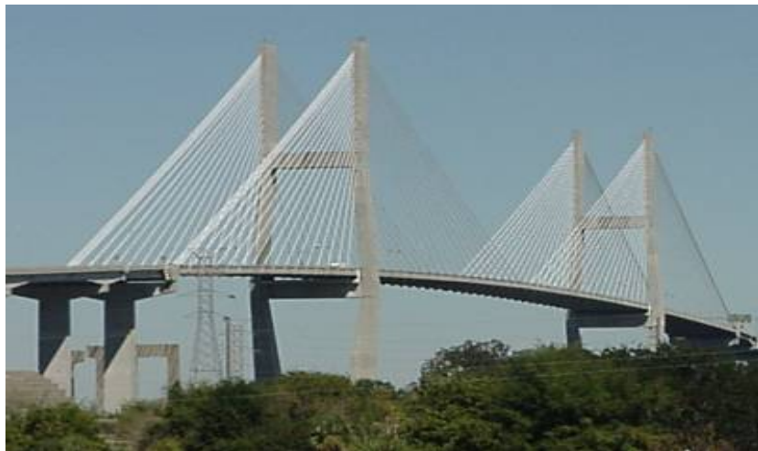
Figura 2.40 – Ponte localizada próximo à Savannah, Geórgia. Disponível em: < http://www.science.howstuffworks.com/bridge >
