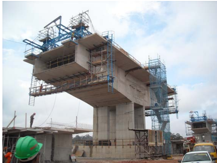
Figura 3.11 - Montagem por balanços sucessivos (Ponte sobre a Represa Billings, São Paulo, 2009).
