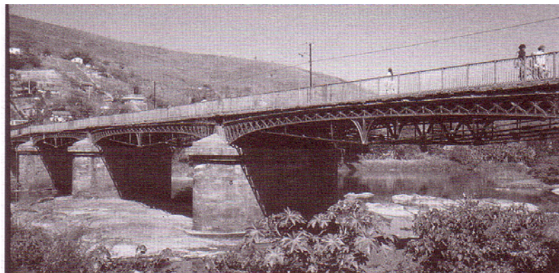
Figura 2.7 – Ponte sobre o rio Paraíba do Sul. Disponível em: < http://www.inepac.rj.gov.br/modules/guia/images >
