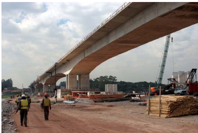
Figura 5.71 – Vão completo da ponte executado.
