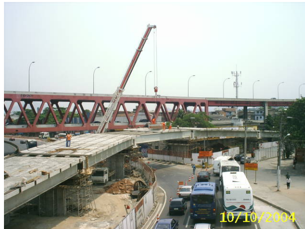
(b) Viaduto de acesso à Linha Vermelha, Rio de Janeiro, RJ, montagem com guindaste (cortesia da Premag®).
