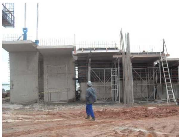
Figura 5.66 – Pátio de fabricação e estocagem das aduelas no trecho do aterro
