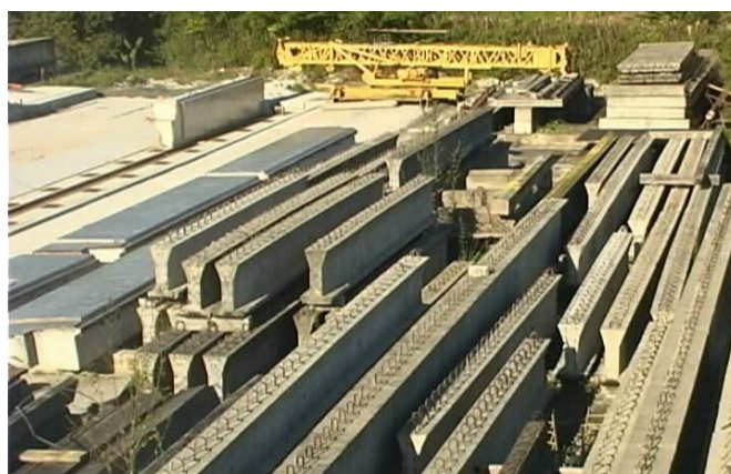
Figura 5.13 – Estoque das peças concretadas.
