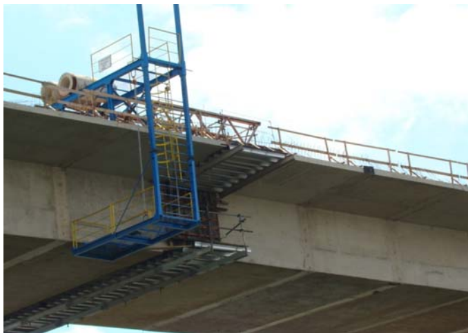
Figura 5.70 – Fechamento do vão central.
