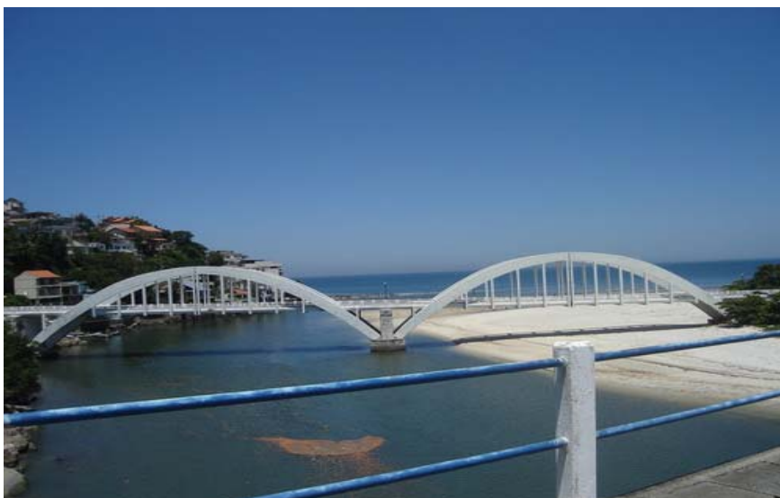
Figura 2.35 – Ponte de Marambaia. Disponível em: < http:// www.panoramio.com >
