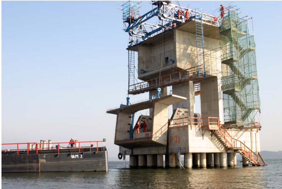
Figura 5.59 – Início do içamento da primeira aduela lançada na represa.
