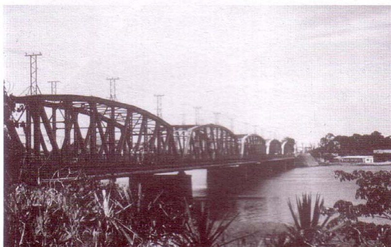
Figura 2.11 - Ponte Barra do Piraí. Disponível em: < http://www.wikipedia.org >
