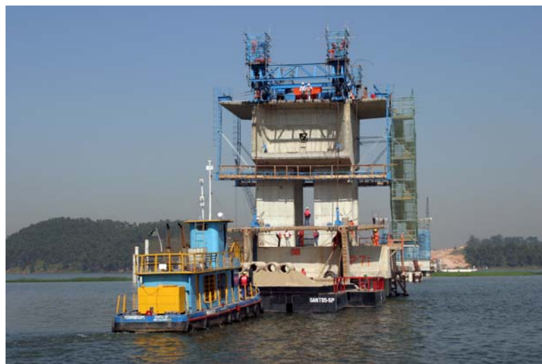
Figura 5.58 – A primeira aduela chegando pela balsa ao local do içamento.
