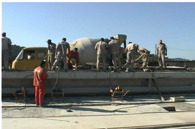
Figura 5.10 - Concretagem de uma viga com caminhão betoneira.
