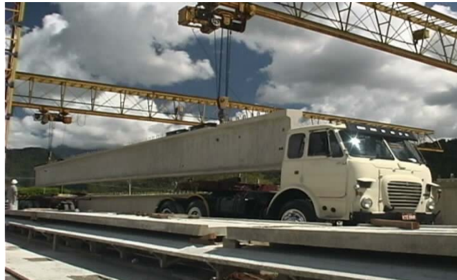
Figura 5.14 - Colocação da viga sobre o caminhão que a transporta para obra.
