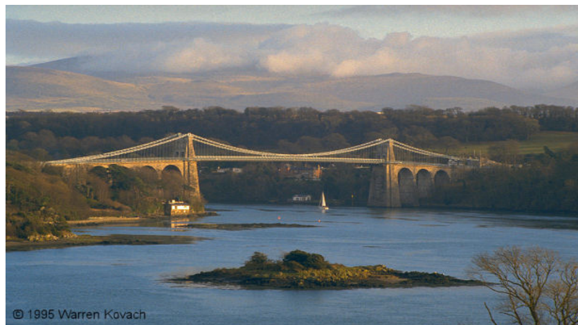
Figura 2.17 – Ponte sobre o Estreito de Menai. Disponível em: < http://www.lmc.ep.usp.br/people/hlinde/estruturas/menai.htm >
