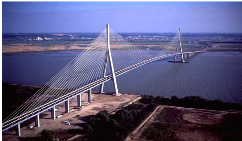
Figura 2.26 – Ponte da Normandia. Disponível em: < http://www.matsuo-bridge.co.jp/english/bridges >
