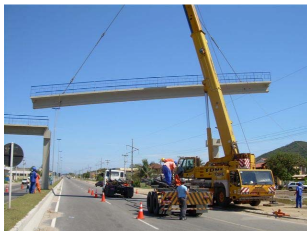
(d) Passarela sobre a RJ-106, São Pedro D'aldeia, RJ, montagem com guindaste (cortesia da Premag®).
