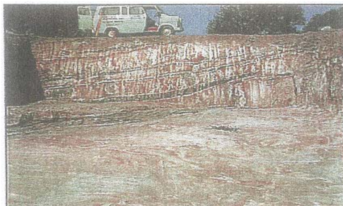
Figura 5.23 - Escavação para o Encontro A (HIGGINS; MATT, 1983).
