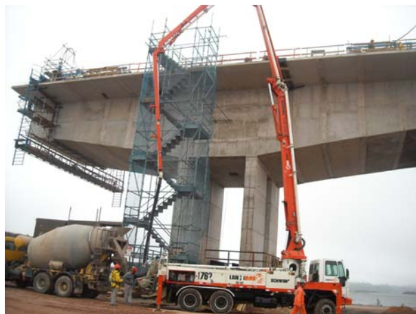
Figura 5.69 – Concretagem do anel de ligação.
