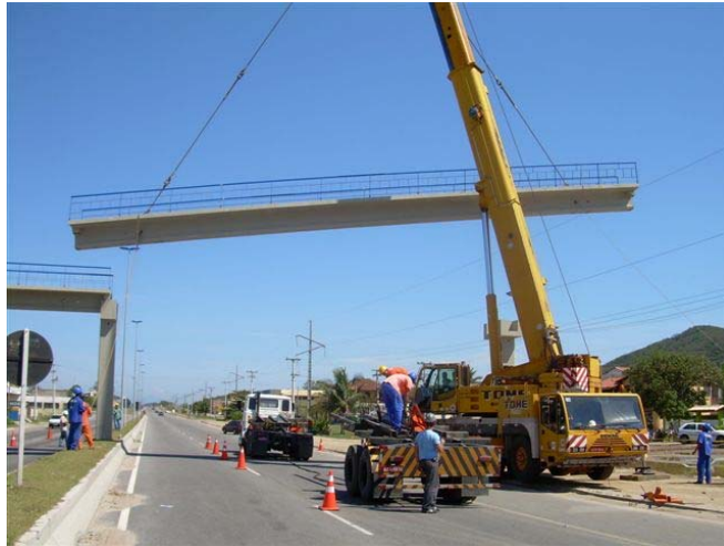
Figura 3.18 - Montagem de passarela para pedestres fabricada em usina de fabricação (cortesia Premag ® ).
