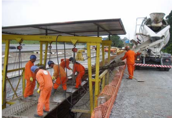
Figura 5.45 - Pátio de fabricação das vigas. Lançamento do concreto nas fôrmas por meio do caminhão betoneira, com utilização do pórtico manual sobre trilhos.
