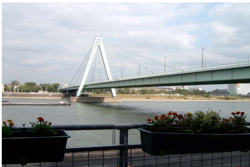
Figura 2.21 – Ponte Severin. Disponível em: < http://www.wikipedia.org >
