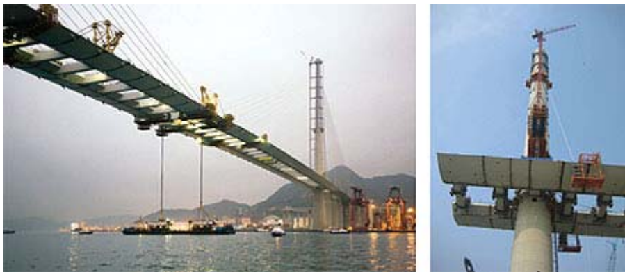
Figura 3.17 - Macaco hidráulico utilizado na montagem da Ponte Stonecutters Bridge, em Hong Kong, China. Disponível em: < http://www.revistatechne.com.br >.
