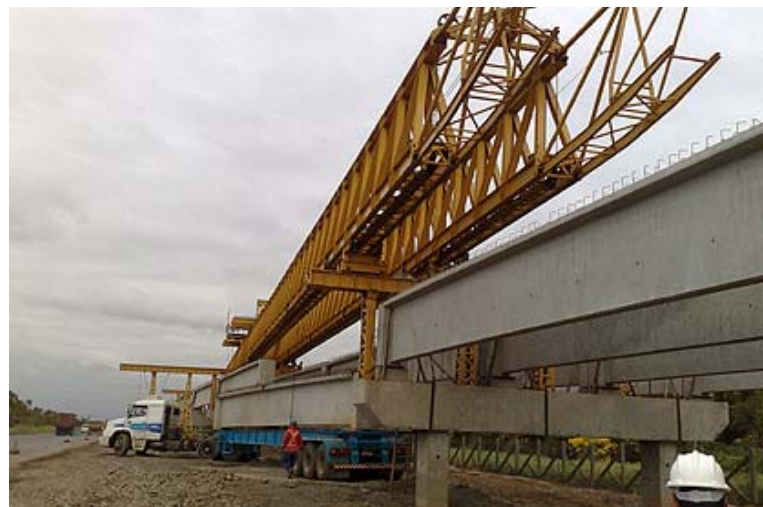
Figura 3.15 - Treliça lançadeira - Construção da Ponte sobre o rio Marombas, Santa Catarina, 2006. Disponível em: < http://www.serradaprata.com.br/construcao-civil >.
