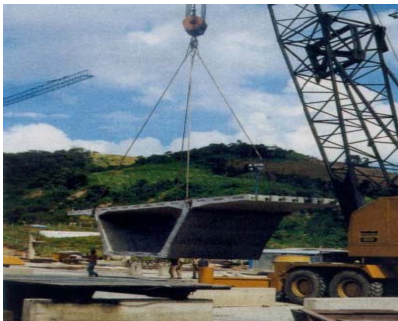
Figura 3.3 - Içamento de aduela pré-moldada (FIB, 2000 apud MATTOS, 2001).
