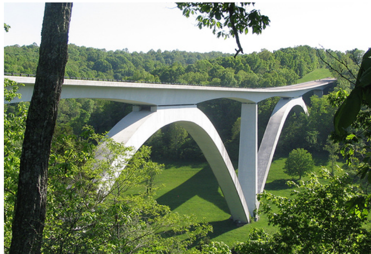
Figura 2.15 – Ponte “Natchez Trace Parkway”. Disponível em: < http://www.commonswikipedia.org >
