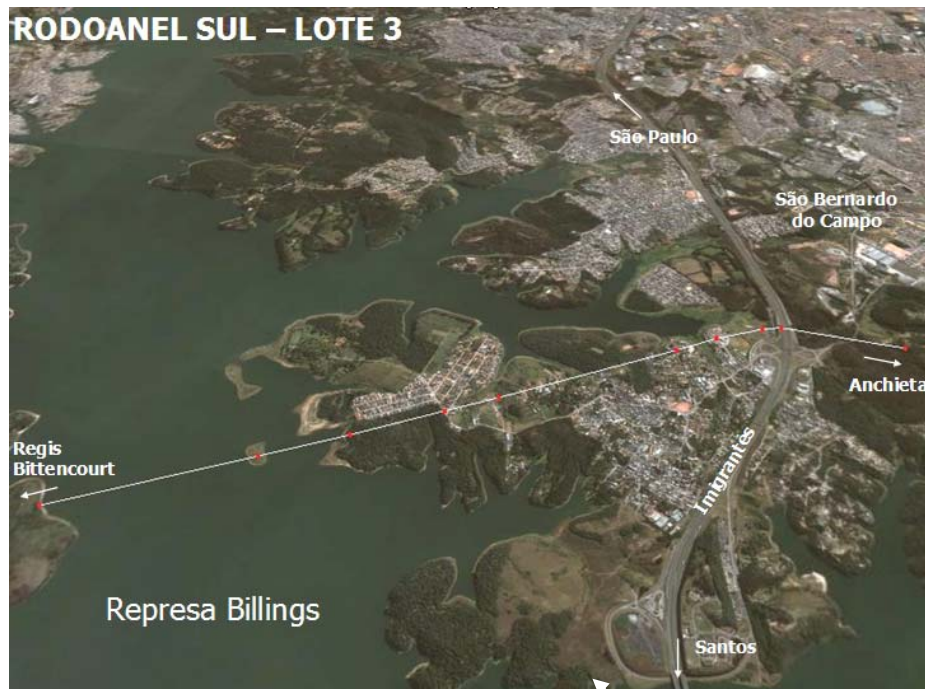
Figura 5.42 - Rodoanel Trecho Sul – Lote 3 (cortesia Consórcio Queiroz Galvão CR Almeida).
