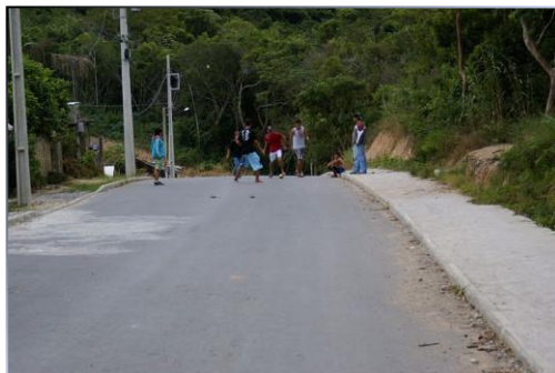
Figura 19 – Obras do PAC. Pavimentação asfáltica parcial da via principal de acesso ao Alto da Caeira do Saco dos Limões. Limite com o Monte Serrat. Fonte: Paulo Roberto Witoslawski (2009).
