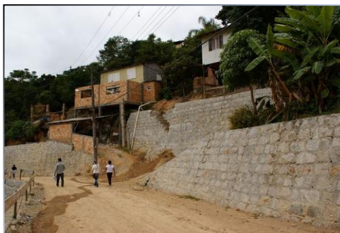
Figura 20 – Obras do PAC. Terraplanagem e muros de contenção na Servidão da Felicidade. Fonte: Paulo Roberto Witoslawski (2009).
