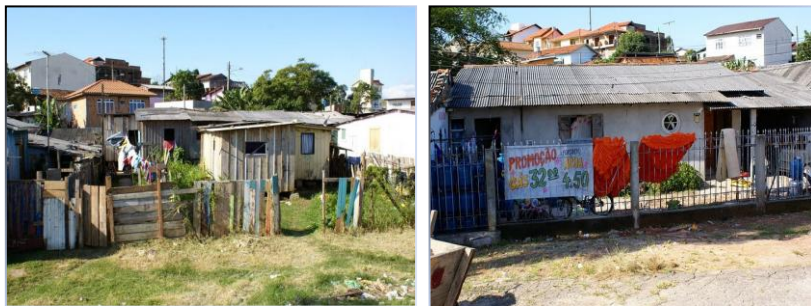
Figuras 21 e 22 – As duas tipologias principais da PC-3. Na primeira imagem é possível perceber a edificação em madeira rústica. Na segunda em imagem podemos visualizar em destaque o cômodo ampliado em alvenaria. Fonte: Paulo Roberto Witoslawski (2009).
