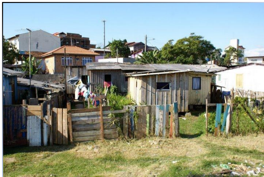
Figura 9 – Vista parcial da comunidade PC-3, na região continental, em 2009. Tipologia habitacional de alta precariedade, característica comum na comunidade. Fonte: Paulo Roberto.
