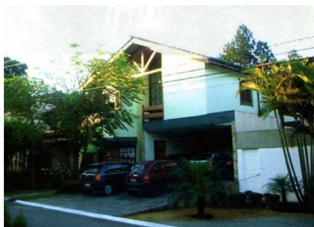
Foto 37. Fachada com insolação insuficiente. 2004.
