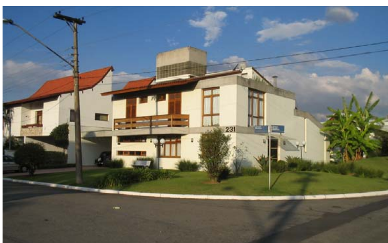
Foto 36. Fachada principal da residência 21, 2006.
