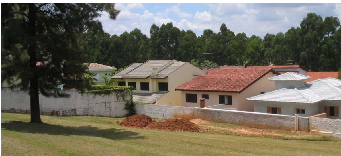
Foto 24. Área de lazer confinada entre a casa e um elevado muro de arrimo, recebendo insolação insatisfatória. 2005.
