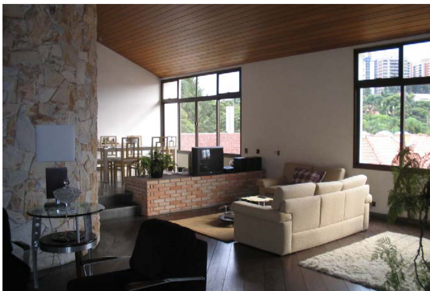
Foto 38. Degraus internos dificultando acessibilidade. 1987.
