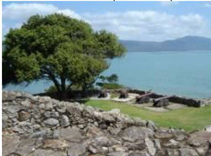
Imagens 153 e 154 - Forte da Ponta Grossa e ocupação próxima.
