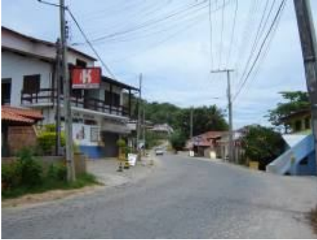
Imagem 122 - Rodovia Baldicero Filomeno tomada por comércios e serviços.
