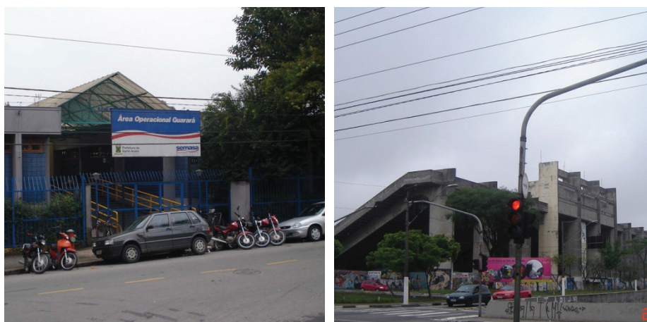
Figuras 10 e 11: Estação de Tratamento de Água (esq.) e Estádio Bruno Daniel (dir.)
